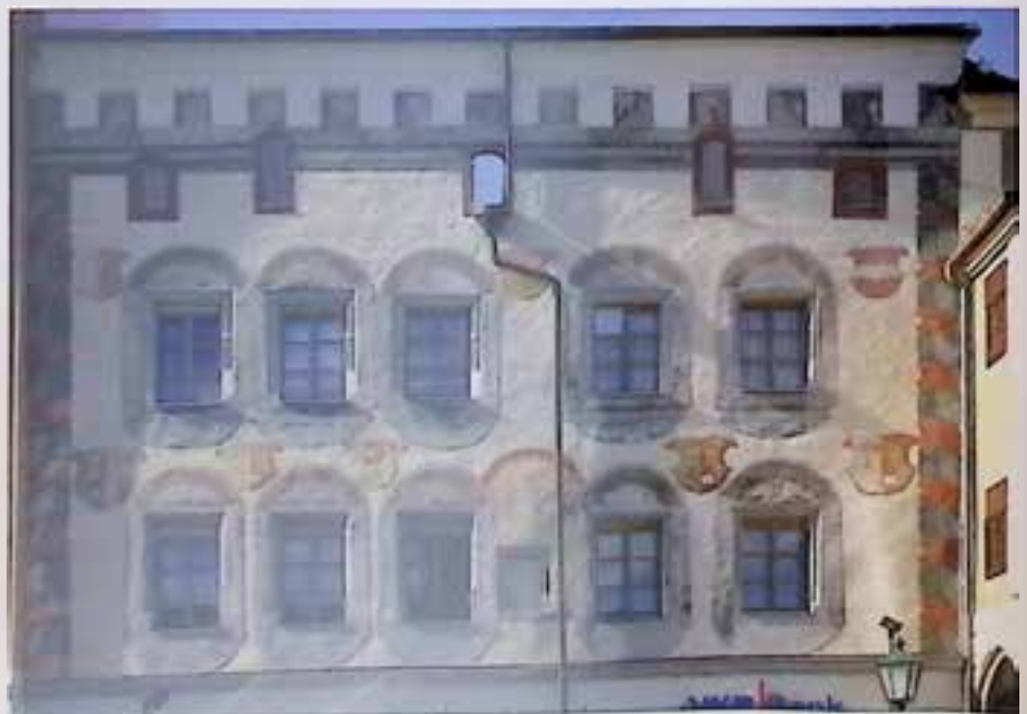
Freistadt, Hauptplatz 2, Restaurierung der Fassadenmalerei
