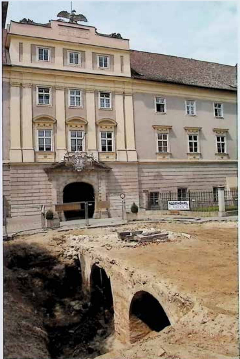
Linz, Promenade, Steinbogenbrücke vor dem Landhaus
