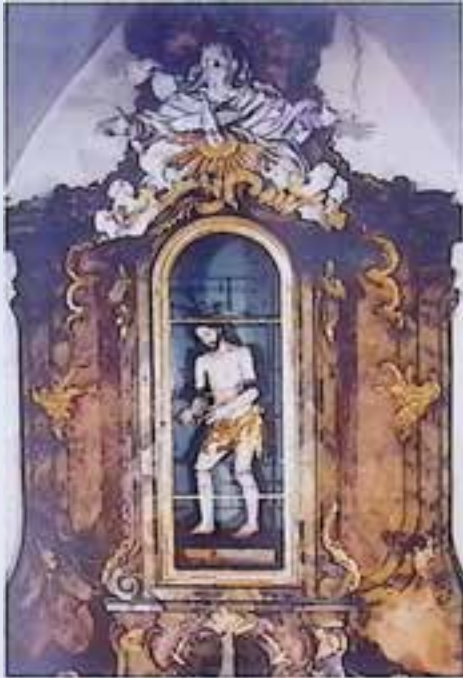
Der Kapellenaltar der Pfarrkirche Antiesenhofen vor der Sanierung. Foto: Bitter
