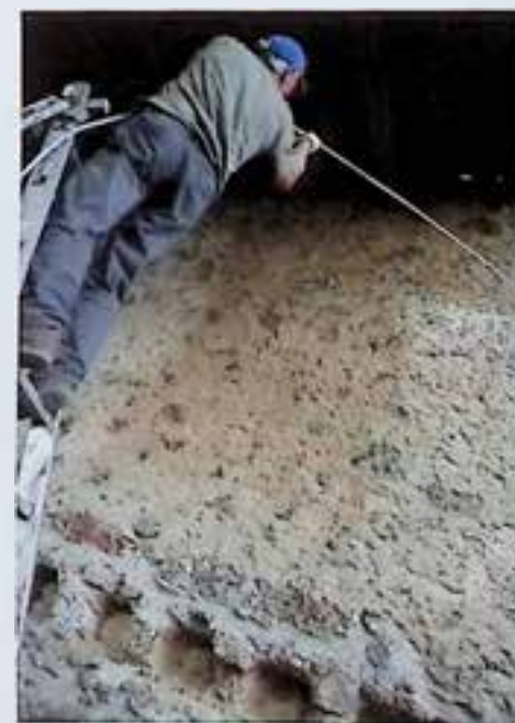
Abb 23: Burgruine Ruttenstein, Sinterwasserfestigung
