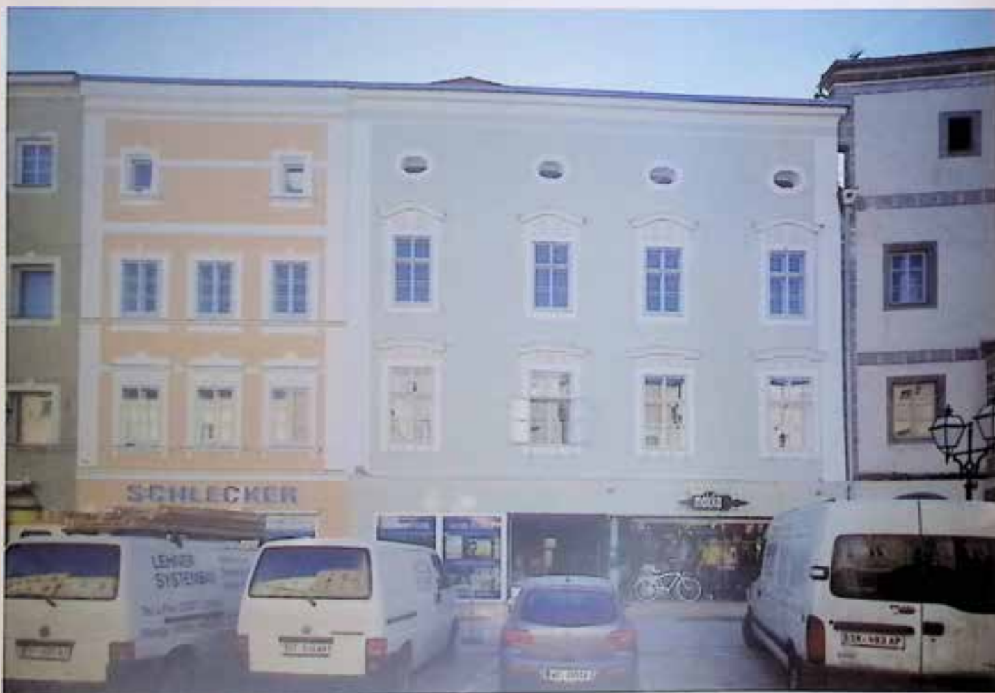
Wels, Stadtplatz 67, Instandsetzung des Bürgerhauses
