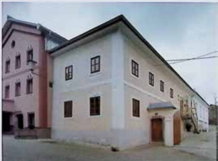
Sarleinsbach, Marktplatz 18, nach Sanierung
