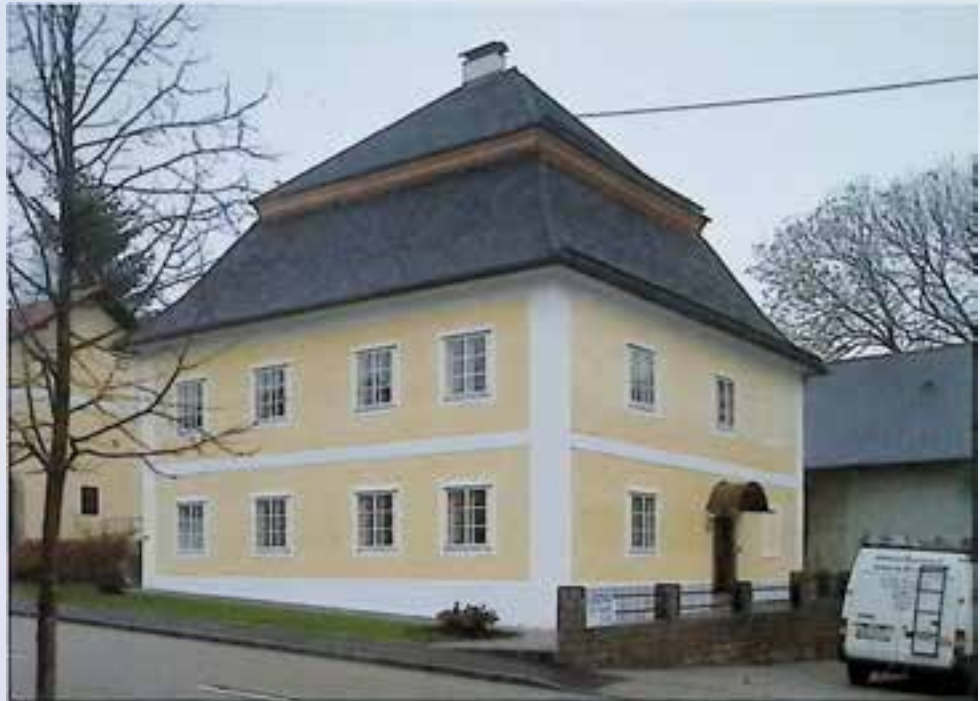
Heiligenberg, Pfarrhof, nach Instandsetzung und Holzschindeldeckung
