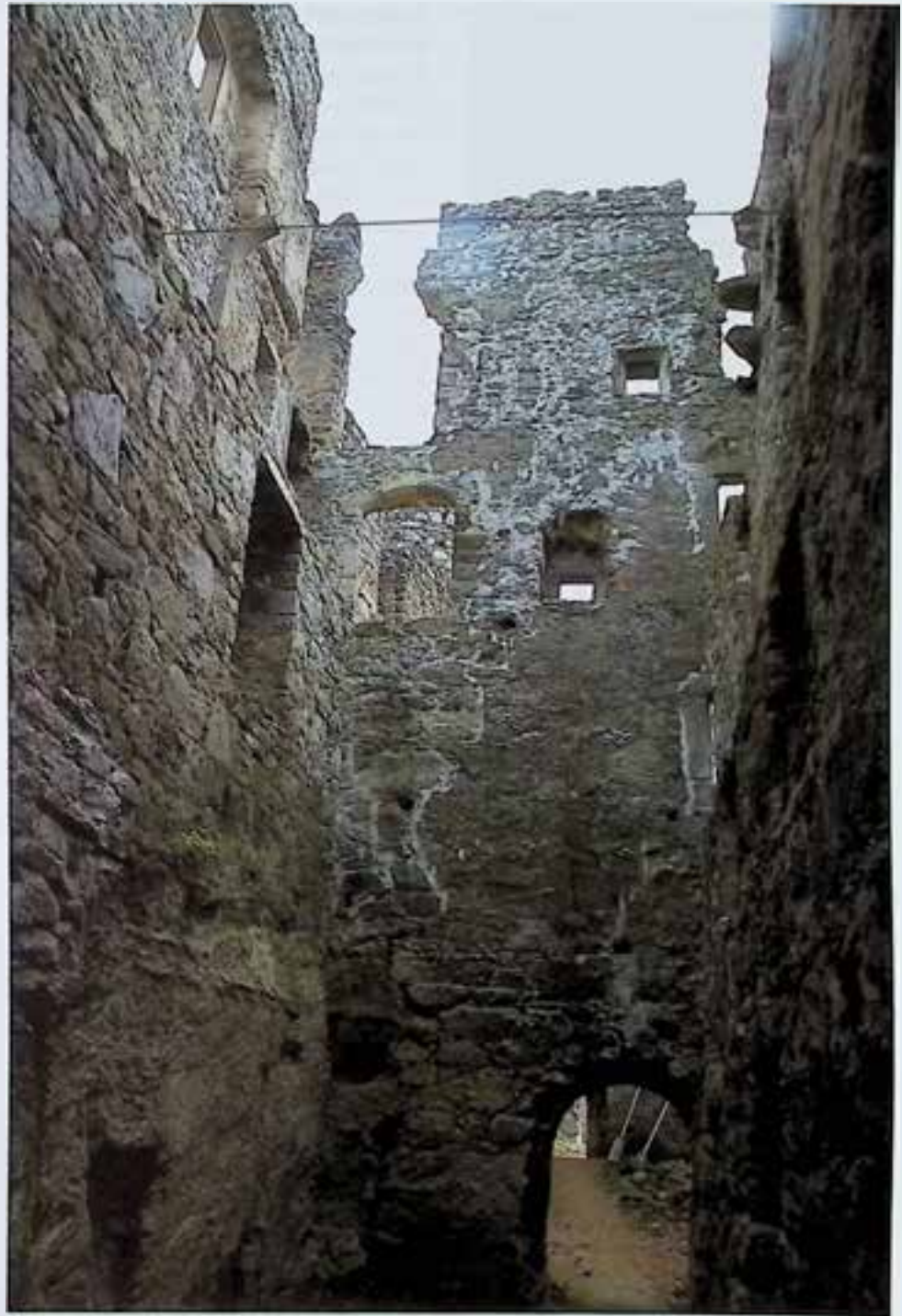
Abb 14: Burgruine Prandegg, statische Zugstange
