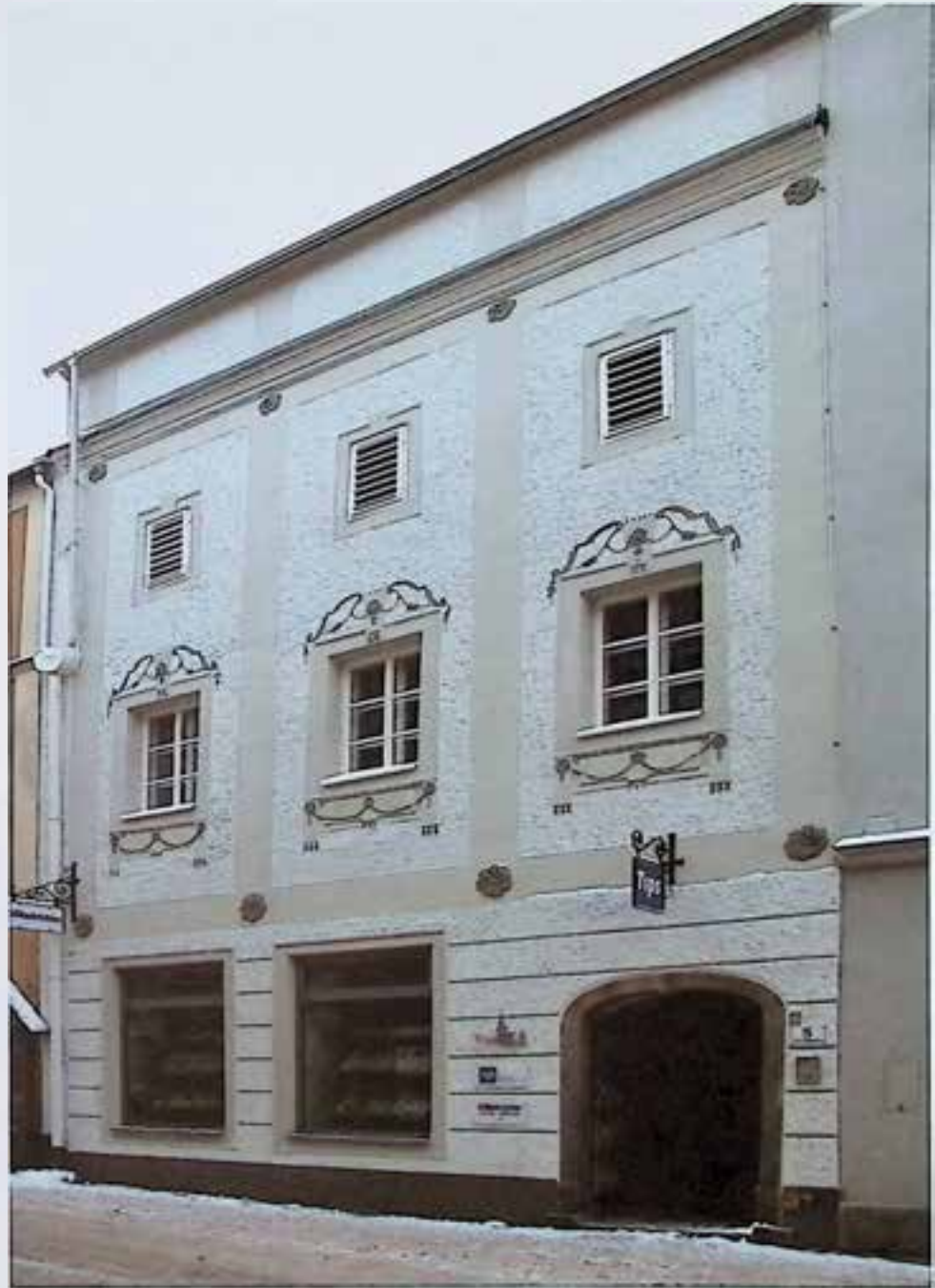
Freistadt, Eisengasse 5, Adaptierung und Fassadensanierung
