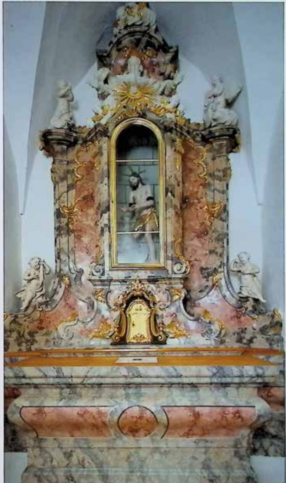
Antiesenhofen, Kapellenaltar aus Stuckmarmor nach Sanierung
