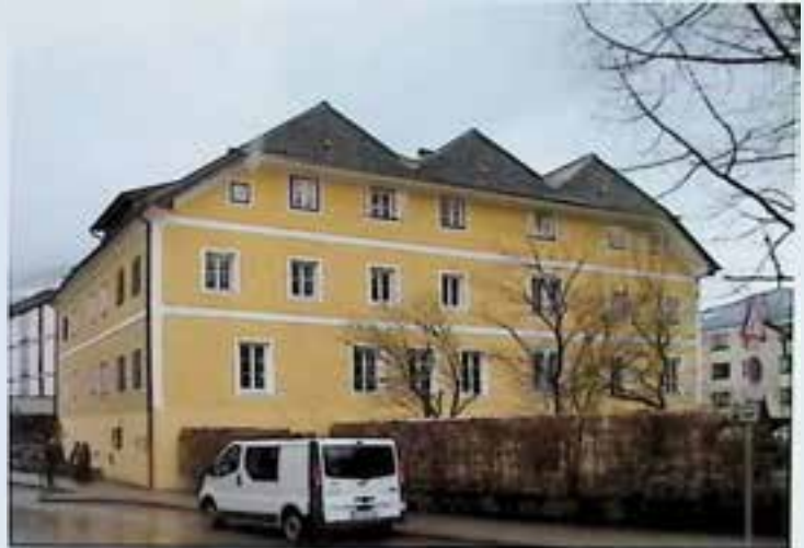
Bad Ischl, Götzstraße 2, Plasmühle, Färbelung in Sumpfkalktechnik
