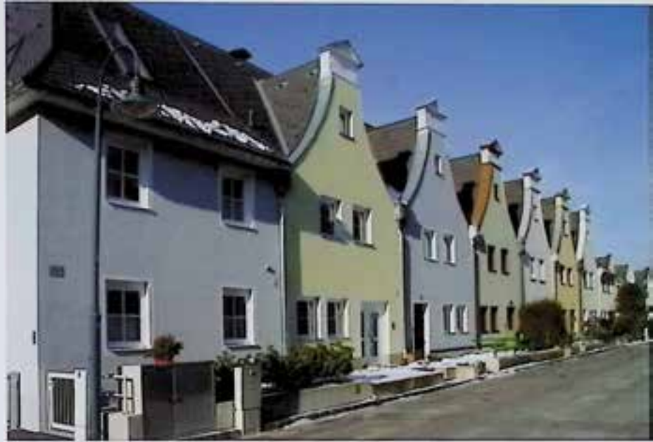
Linz, Siedlung Scharlinz, Haydnstraße. Als klassische Reihenhaussiedlung von C. Kühne 1919 bis 1926 errichtet. Zustand 2005.
