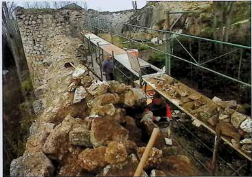
Pierbach, Ruine Ruttenstein, Sicherung der Mauerkronen
