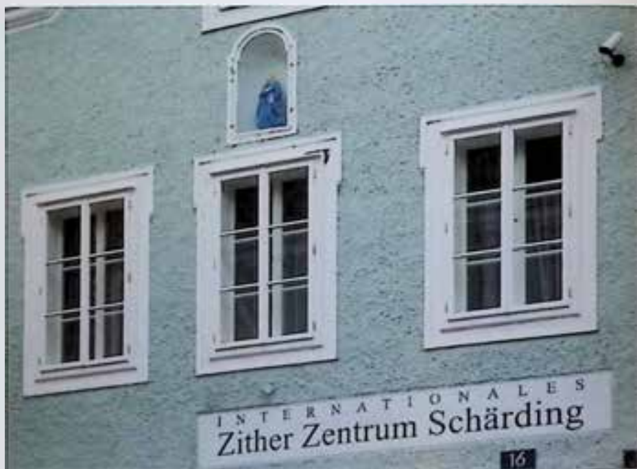
Schärding, Innbruckstraße 16, gelungene Fensterrekonstruktion
