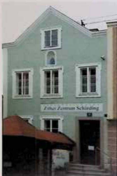
Schärding, Innbruckstraße 16, Denkmalschutz für ehem. Schlosserhaus
