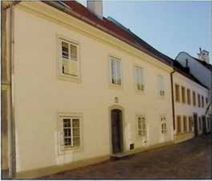
Steyr, Schuhbodengasse 9, ehem. Handwerkerhaus nach Instandsetzung. Foto: Hans-Jörg Kaiser
