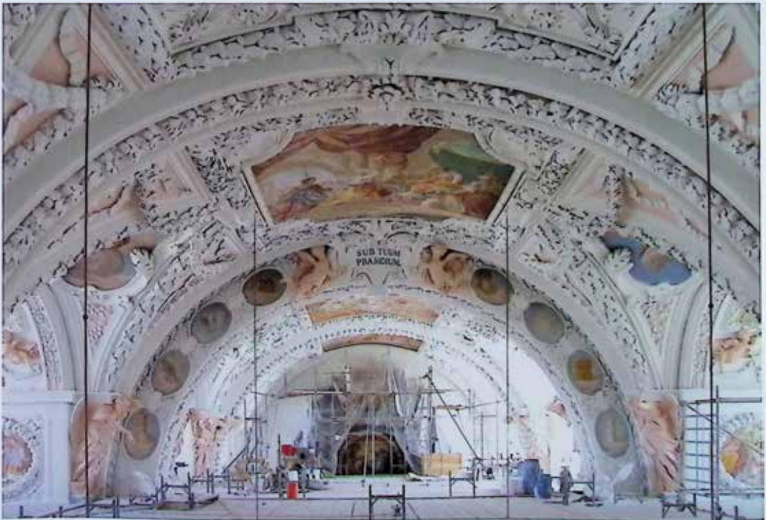
Garsten, ehem. Stiftskirche, Gewölbe während Restaurierung. Foto B. Heindl
