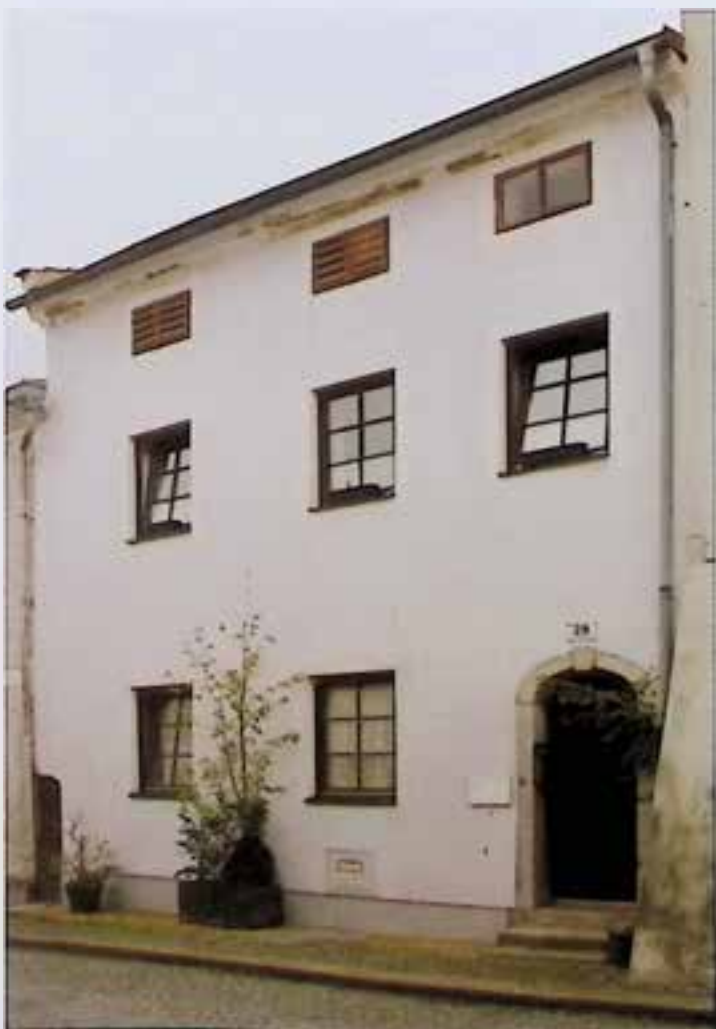
Freistadt, Salzgasse 28, Denkmalschutz 2006
