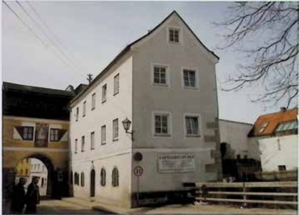
Schärding, Passauer Straße 1, Denkmalschutz 2006
