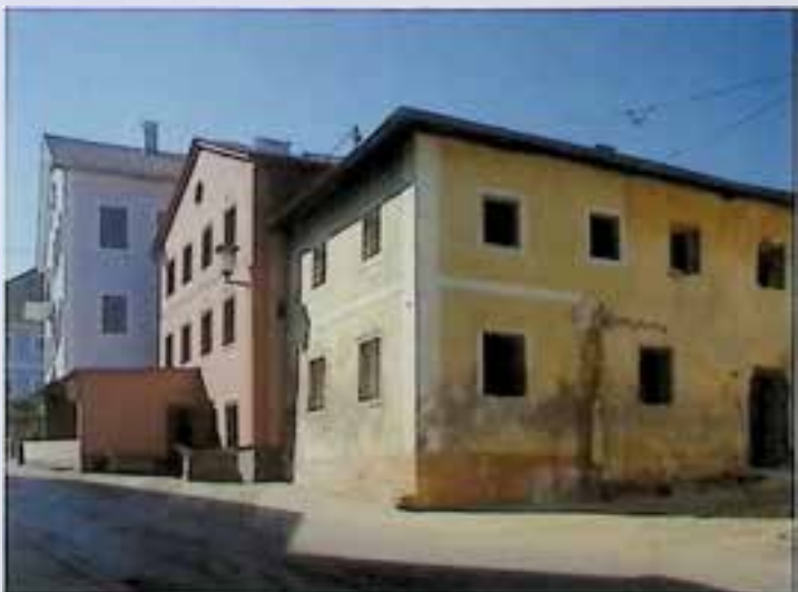
Sarleinsbach, Marktplatz 18, vor Instandsetzung
