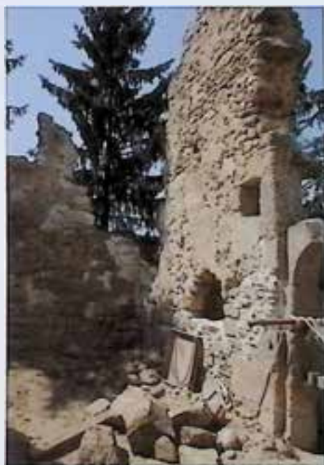
Abb 6: Burgruine Prandegg, freistehendes Mauerwerk
