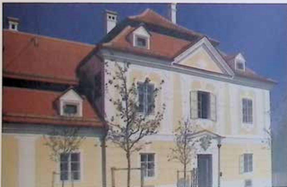
Wilhering, Höferstraße 2, umfassende Restaurierung für ehem. Hofrichterhaus
