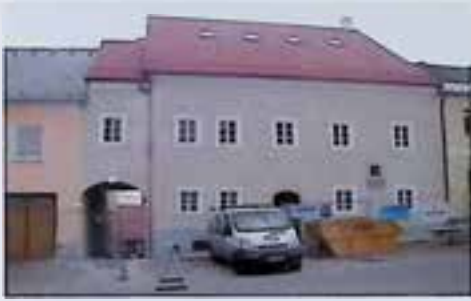
Oberneukirchen, Marktplatz 9, Schnopfhagenhaus nach Instandsetzung
