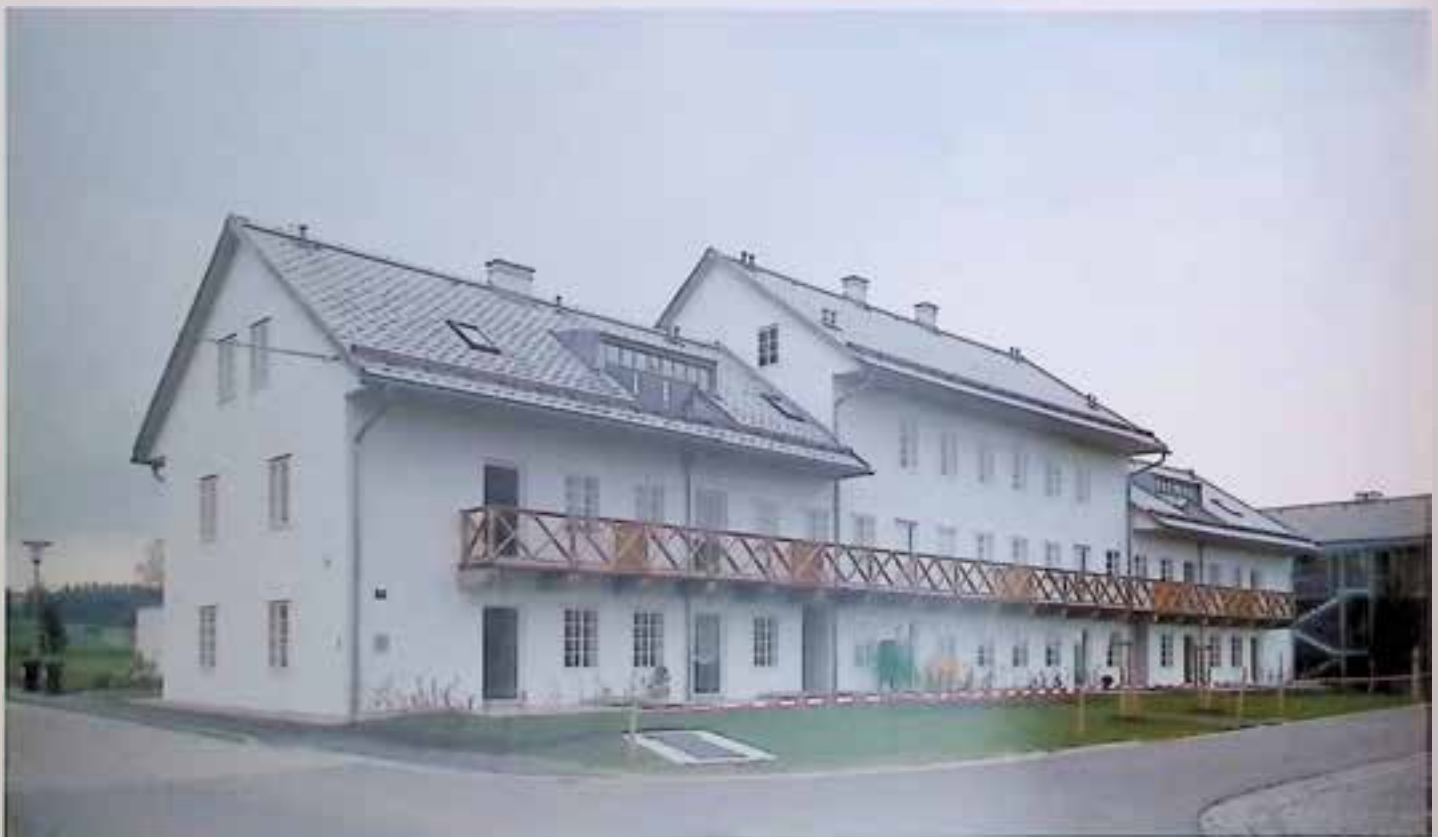
St. Martin im M., Plöcking 27-30-31, ehem. Arbeiterwohnhäuser nach Instandsetzung
