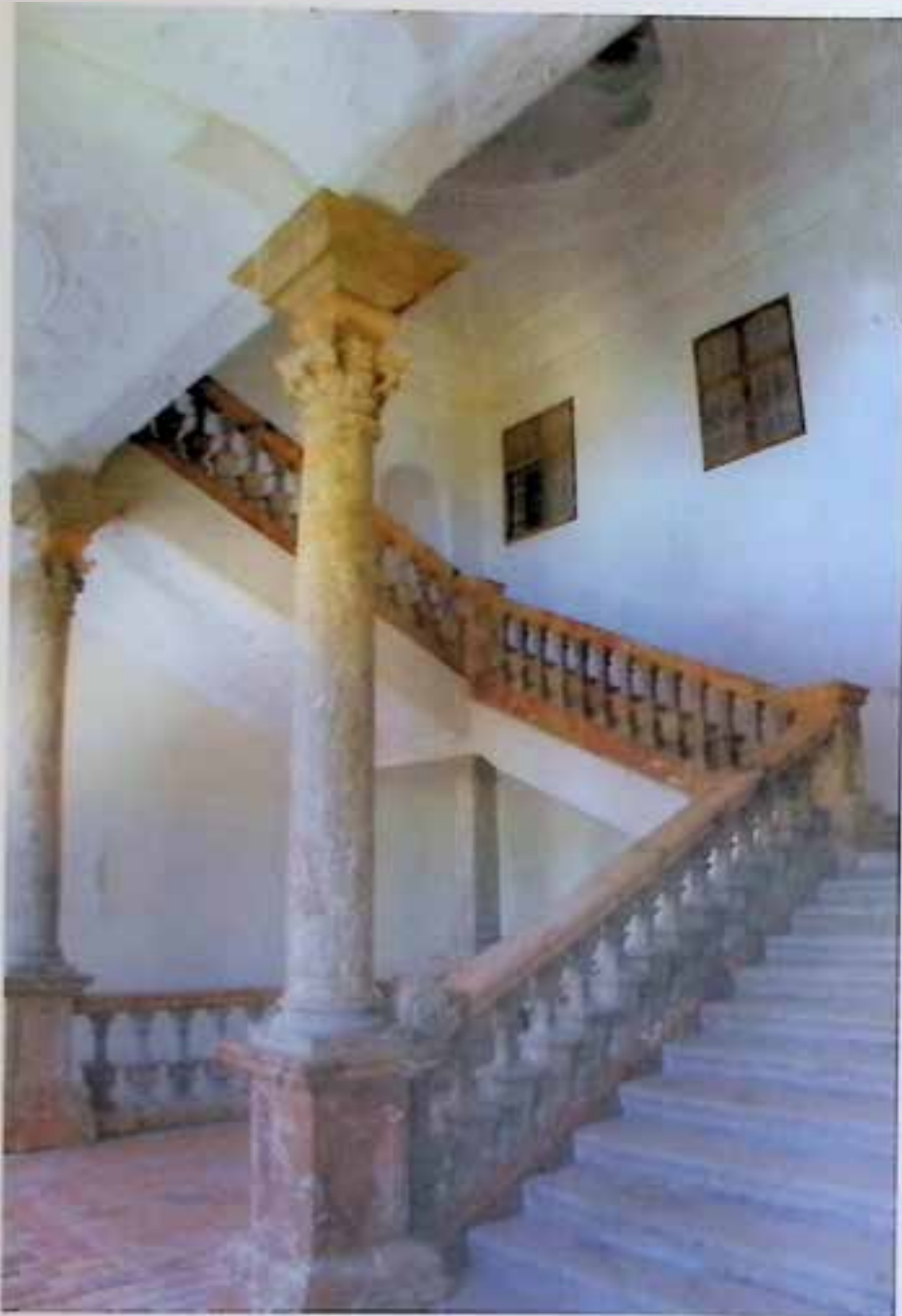
Die originalgetreu ergänzte und sanierte Stiegenanlage; im Steinbruch am Schwarzensee konnte passendes Material abgebaut werden. Bearbeitung durch CNC-Fräsen und handische Nachbearbeitung. Foto: Kienesberger
