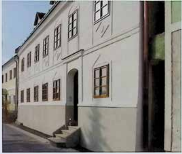
Steyr, Wieserfeldplatz 44, Instandsetzung im Ensemble Steyrdorf. Foto: Hans-Jörg Kaiser
