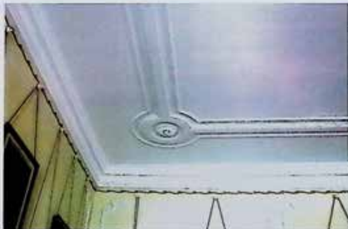
Schloss Starhemberg, Eferding: Stucksanierung. Foto: Starhembergsche Familienstiftung
