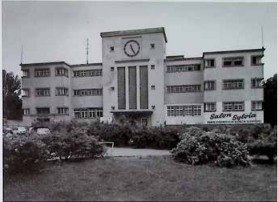
Untere Donaulände 11, Parkbad, erbaut 1929-30 von C. Kühne.
