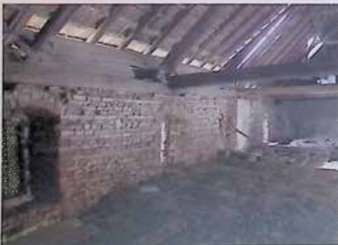
Außenmauern aus Flusststeinen und Ziegeln – eine regionaltypische Technik
