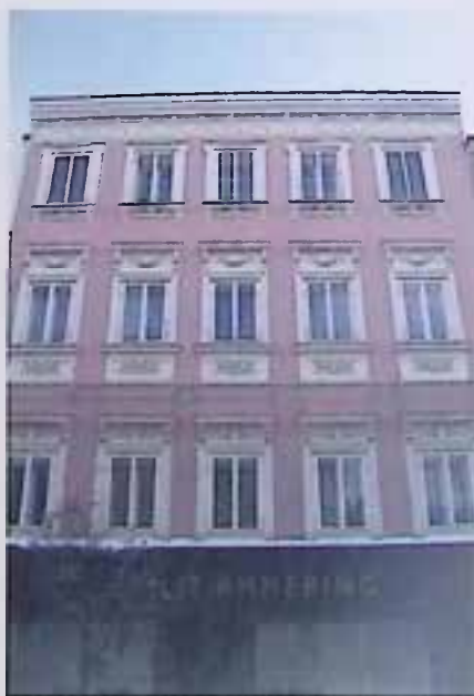
Ried im Innkreis, Rossmarkt 24, Denkmalschutz 2006
