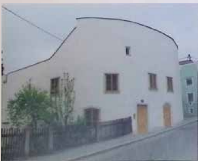
Schärding, Innbruckstraße 24, mit Kalkputz sanierte Außenhaut
