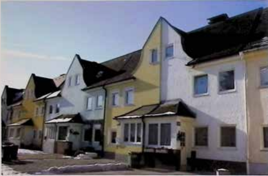
Linz, Siedlung Scharlinz. Kein Denkmalschutz. Verlust der einheitlichen und subtilen architektonischen Details an Türen und Fenstern.
