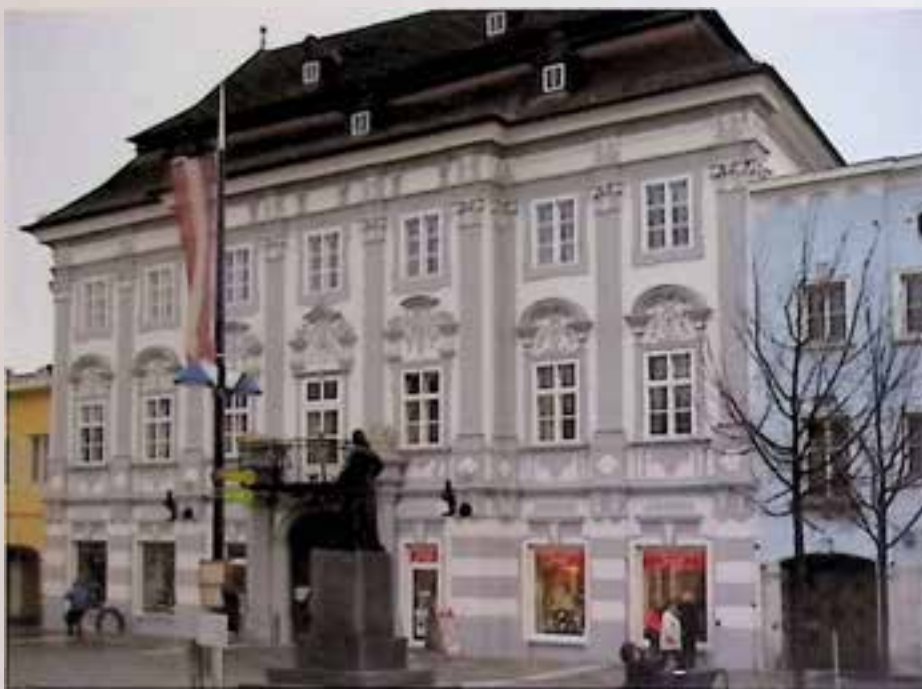
Wels, Kaiser Josef Platz 12, nach Außensanierung
