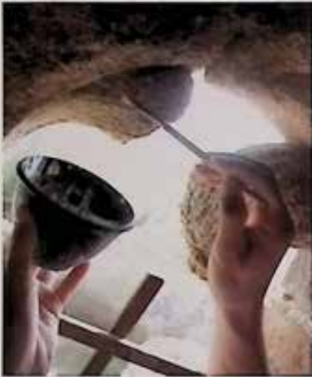
Abb 24: Burgruine Rutenstein, Werksteinfestigung
