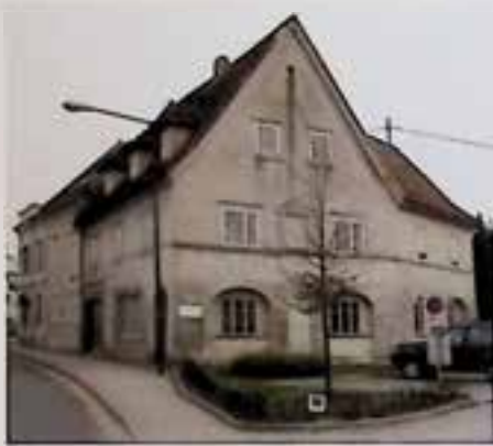
Eferding, Josef-Mitter-Platz 6, Denkmalschutz für Bau aus der Zwischenkriegszeit
