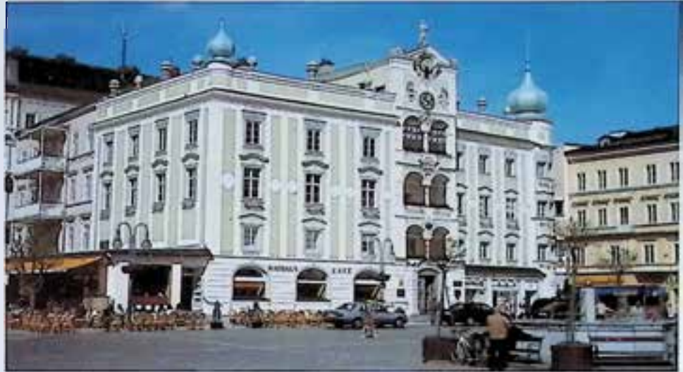
Gmunden, Rathaus, nach Fassadenfärbelung. – Foto: BDA.
