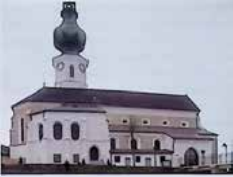
Aspach, Pfarrkirche, nach Außenrestaurierung. Foto: BDA.
