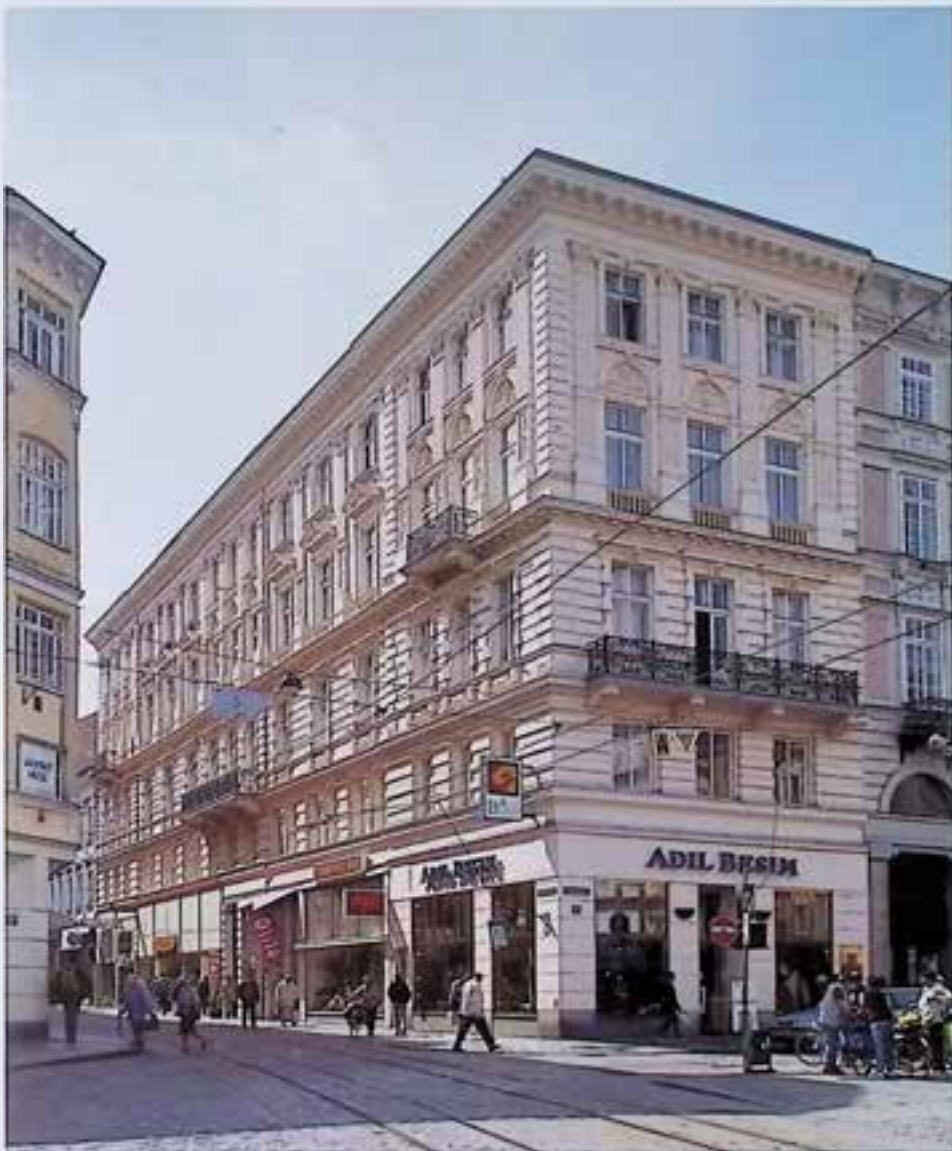
Linz, Hauptplatz 25 – Schmidtorstraße 2, nach Fassadeninstandsetzung. – Foto: BDA.
