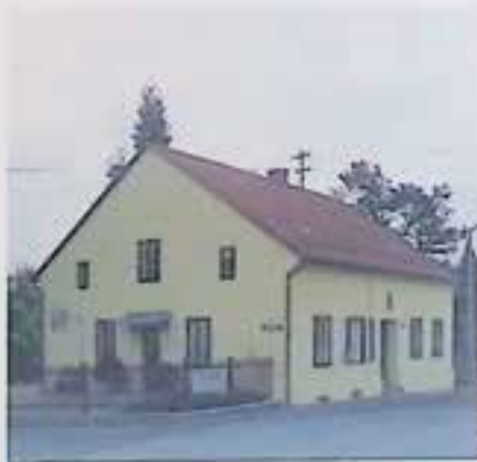
Leonding, Michaelsbergstraße 16, nach Instandsetzung. – Foto: BDA.
