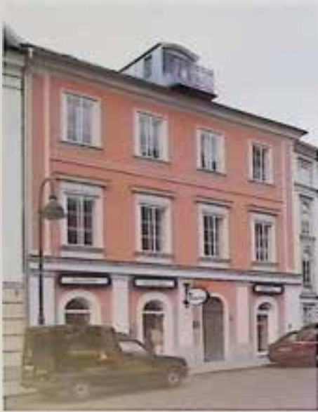
Linz, Promenade 29, nach Instandsetzung von Fenstern und Dachgaube. – Foto: BDA.
