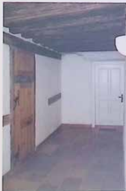
Braunau, Altstadt 16, Obergeschossflur mit Fachwerkwand und Holzbalkendecke. Foto: tech-3.
