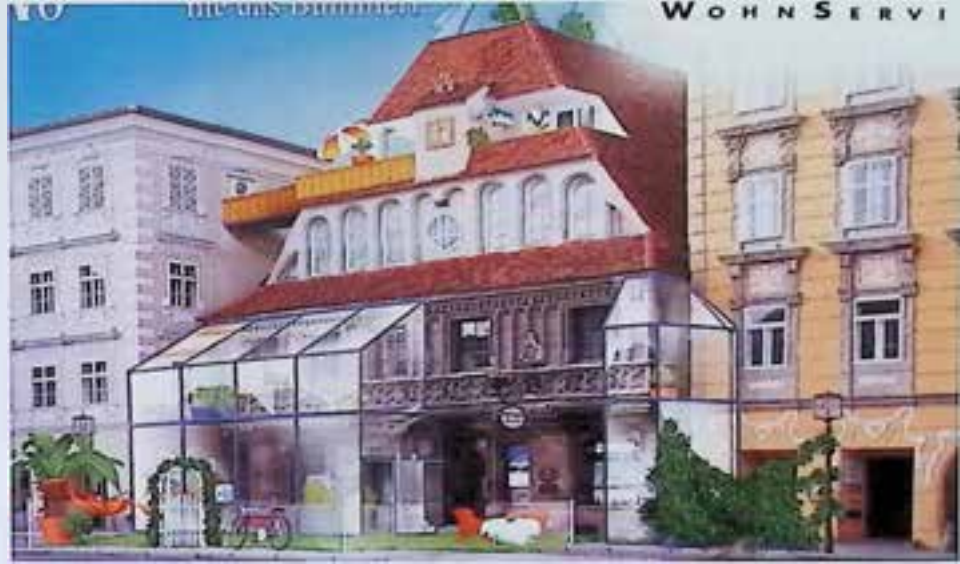
Austauschbar: Das Bummerlhaus in Steyr wird – augenzwinkernd – als „zeitgemäßes“ Wohnhaus adaptiert (Werbeplakat). – Foto: BDA.
