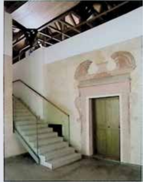
Freistadt, Salzgasse 15, Salzhof; gemalte Türeinfassung nach Freilegung und Rekonstruktion. – Foto: BDA.
