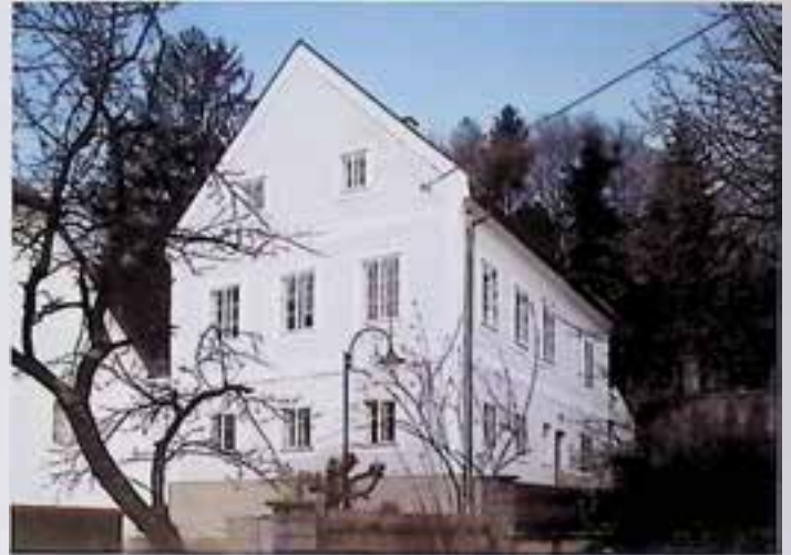
Steyr, Wieserfeldplatz 50, nach Adaptierung und Instandsetzung. Foto: BDA.
