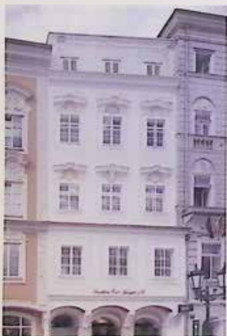
Linz, Hauptplatz 20, Spätbarockfassade nach Restaurierung. – Foto: A. Heidl.
