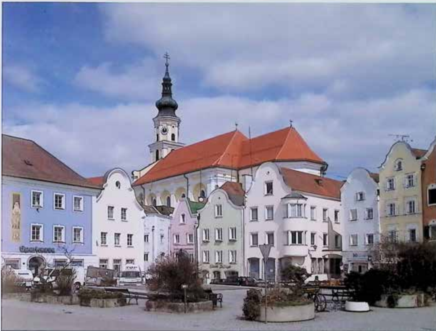
Schärding, Stadtpfarrkirche, Blick vom Stadtplatz nach Neueindeckung. – Foto: BDA.
