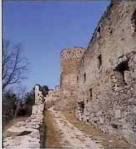
Burgruine Prandegg, Blick von der Vorburg mit den Wirtschaftsbauten über den Bergfried zur Wohnburg. – Foto: BDA.
