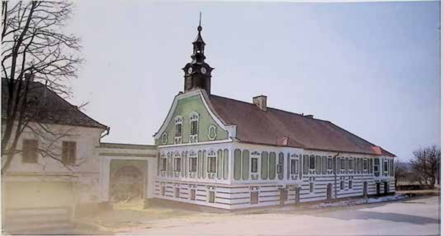
Hinterweissenbach 32, Löfflergut, Wohnhaus nach Fassadenrestaurierung. – Foto: BDA.
