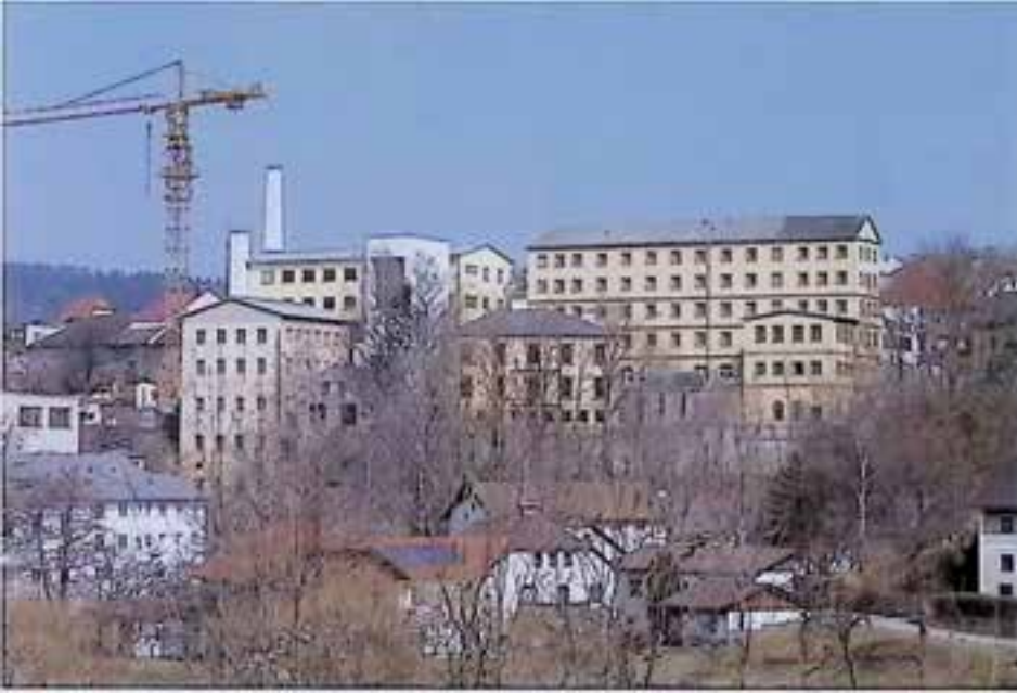
Haslach a.d.M., Stelzen 13-16, ehem. Textilfabrik Vouwiller, während Adaptierung. – Foto: BDA.
