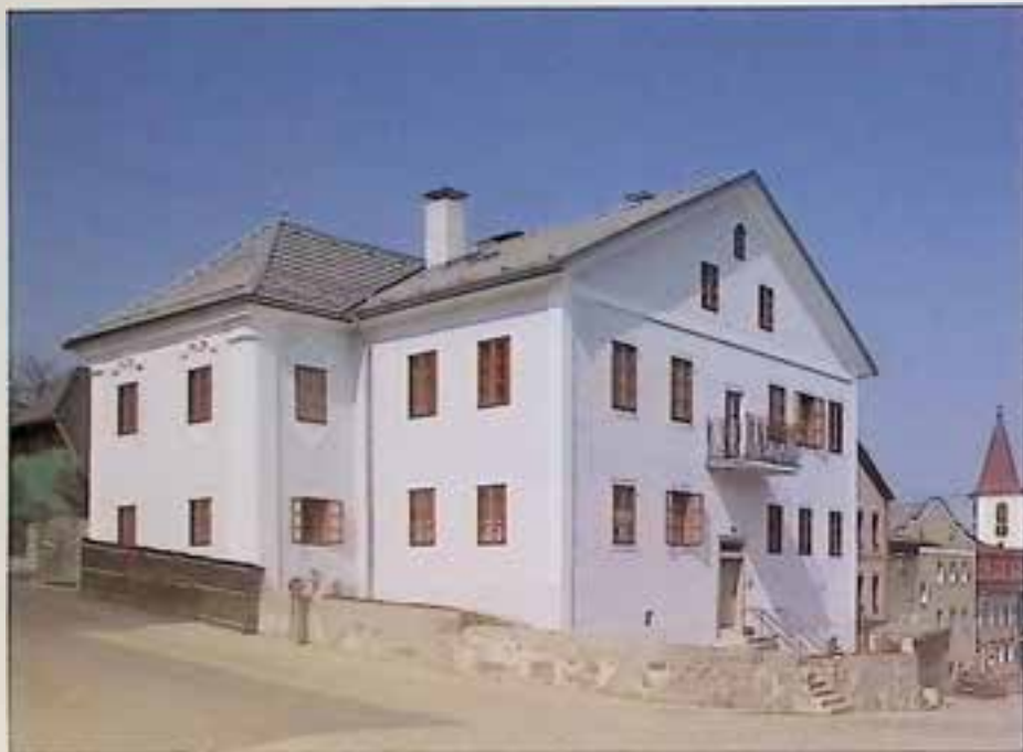
Sarleinsbach, Markt 22, nach Instandsetzung. – Foto: BDA.
