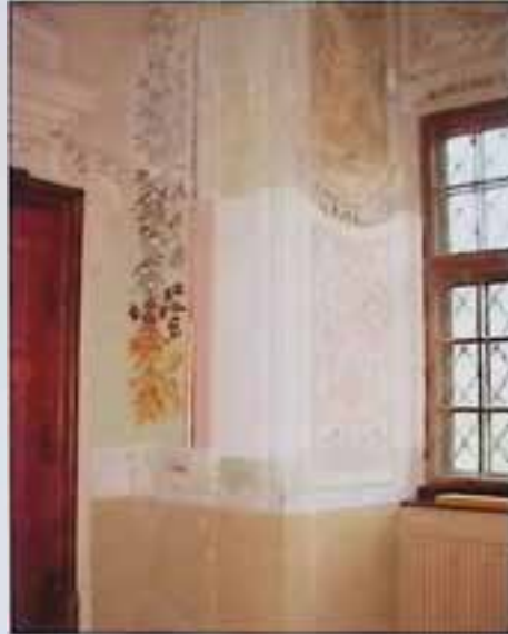
Lambach, Stift, Sommerrefektorium, Probe- und Musterachse 2002 mit Freilegung und Wiederherstellung der Fassung um 1740. Foto: J. Weninger.
