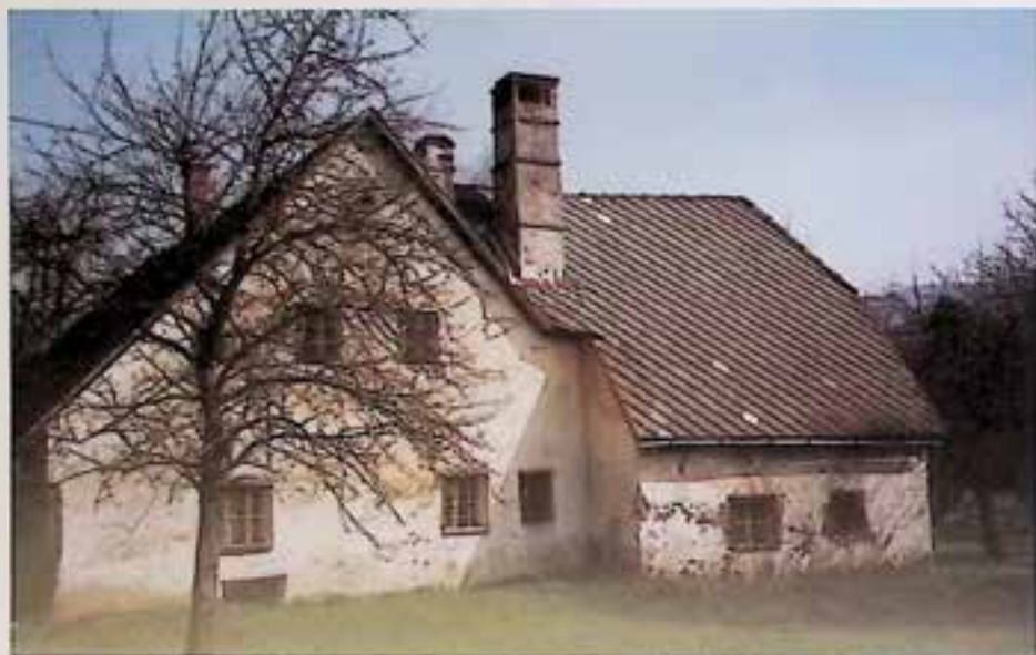
Garsten, Windnerstraße 7, ehem. Binderhaus, Giebelseite mit ehem. Schmiede. – Foto: BDA.
