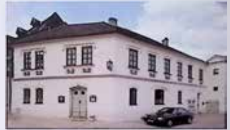
Enns, Schlossgasse 1, nach Fassadenumstandsetzung. – Foto: BDA.
