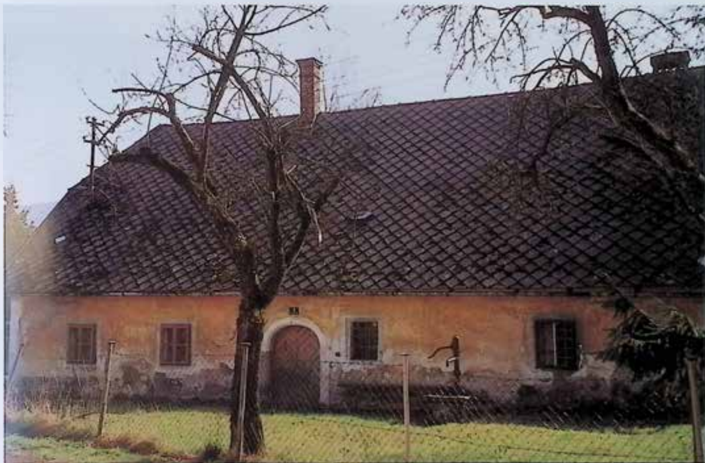
Garsten, Windnerstraße 7, ehem. Binderhaus, straßenseitige Ansicht. – Foto: BDA.
