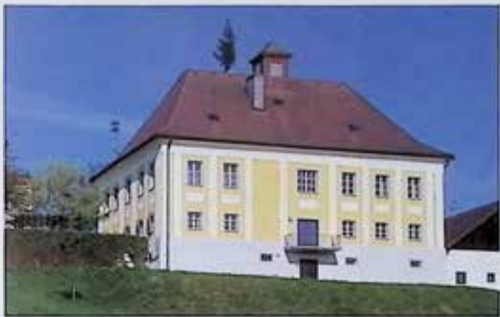
Ohlsdorf, Benefizium, nach Instandsetzung. – Foto: BDA.
