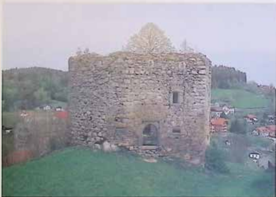
Oberneukirchen, Burgruine Waxenberg, ehem. Batterieturm. – Foto: BDA.
