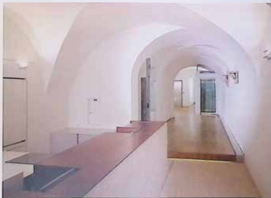
Linz, Hauptplatz 20, Adaptierung der gewölbten Erdgeschosshalle als Kundenservicebereich. Foto: A. Heidl.
