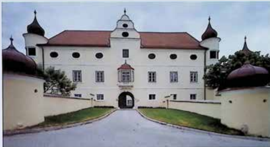
Buchkirchen bei Wels, Pfarrhof, Hauptfassade. – Foto: BDA.
