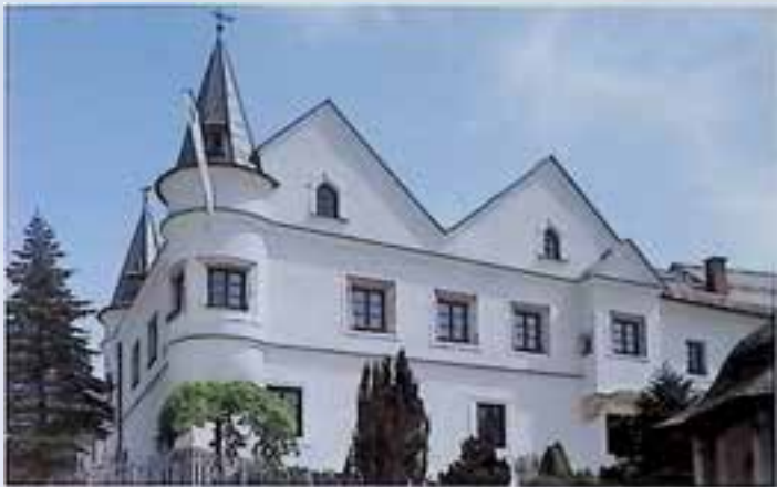
Weyer, Marktplatz 30, Schloss, nach Fassadeninstandsetzung. Foto: BDA.
