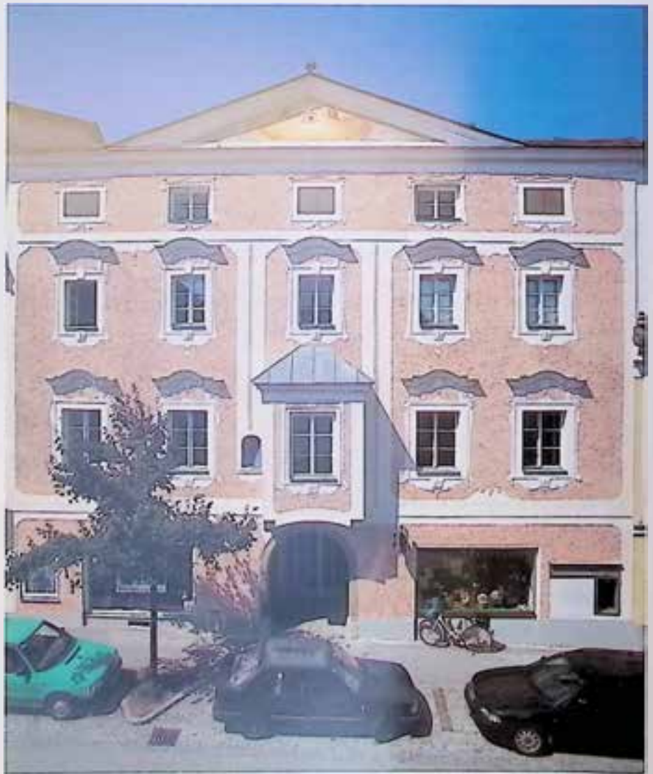
Enns, Mauthausnerstraße 7, nach Fassadenrestaurierung. – Foto: W.Ebenhofer..
