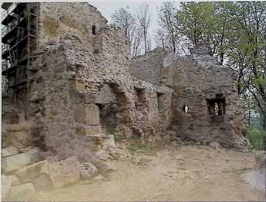
Pierbach, Ruine Rutenstein, während der Konservierungsmaßnahmen. – Foto: BDA.
