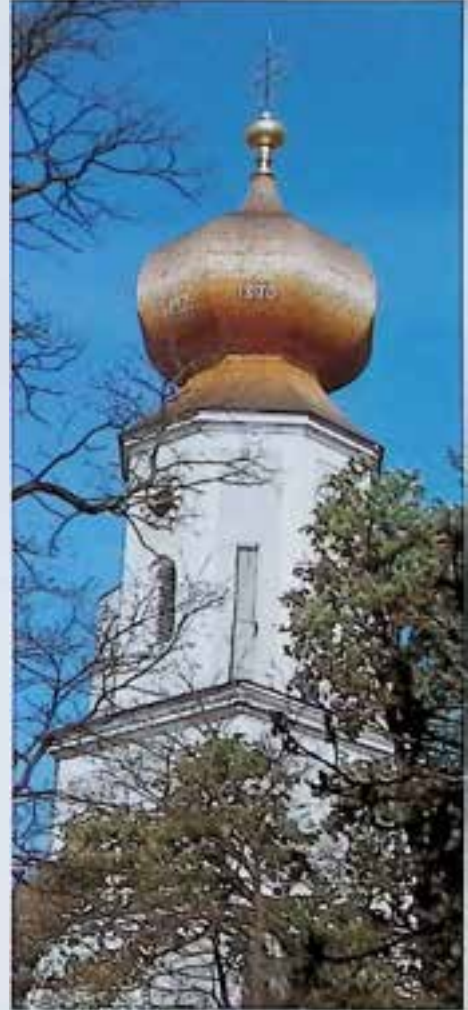
Heiligenstatt, Filialkirche, Turmhelm nach Wiederherstellung der Holzschindeldeckung. Foto: BDA.
