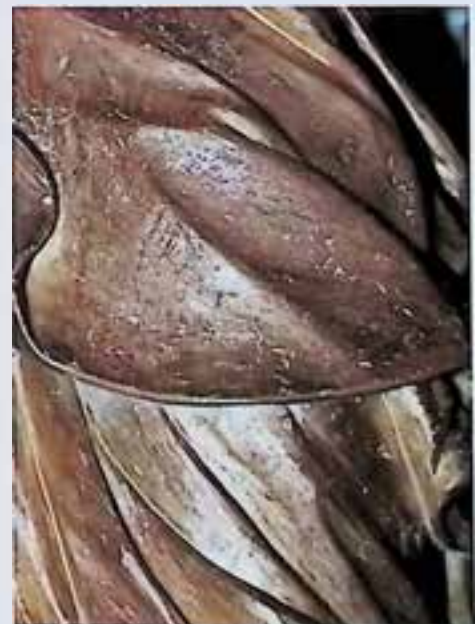
Garsten, Pfarrkirche und ehem. Stiftskirche, Seitenaltar, Schadensbild der 1963/64 verkratzten Originalvergoldungen. Foto: E. Moser-Seiberl.
