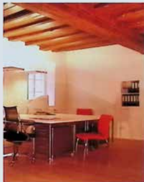
Braunau, Färbergasse 3, Riemlingdecke des 16. Jhts. nach Freilegung und Restaurierung. Foto: Architekturbüro Färbergasse.
