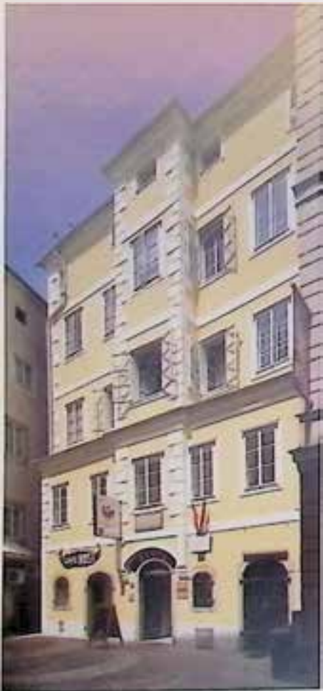
Linz, Rathausgasse 5, nach Fassadeninstandsetzung. – Foto: BDA.
