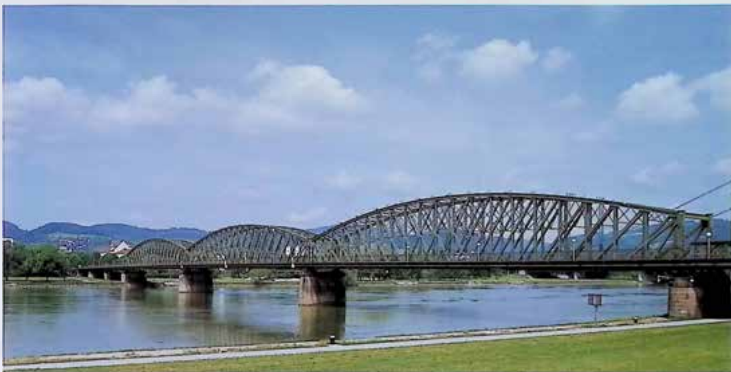
Linz, Eisenbahnbrücke von 1898/99. – Foto: BDA.
