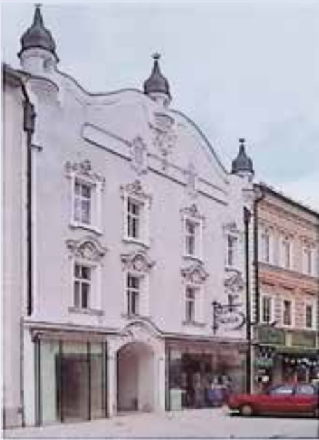
Grieskirchen, Stadtplatz 6, nach Instandsetzung und Adaptierung. – Foto: BDA.
