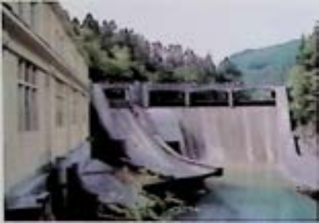
Kraftwerk Steyrdurchbruch, Wehranlage und Triftgasse. – Foto: BDA.
