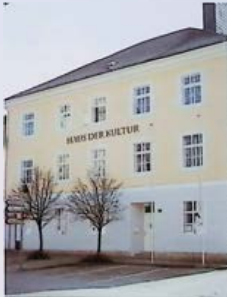
St. Georgen i.A., Attergaustraße 31, nach Instandsetzung. – Foto: BDA
