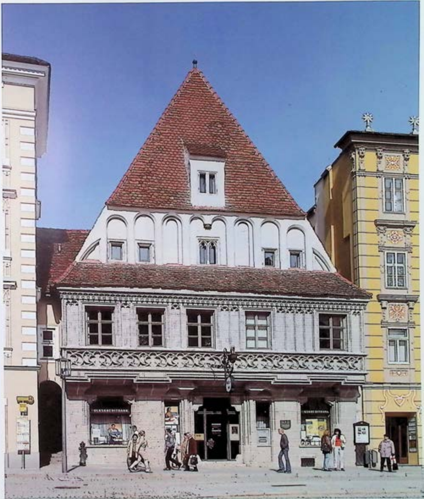
Steyr, Stadtplatz 32, Bummerlhaus, nach Restaurierung. – Foto: BDA
