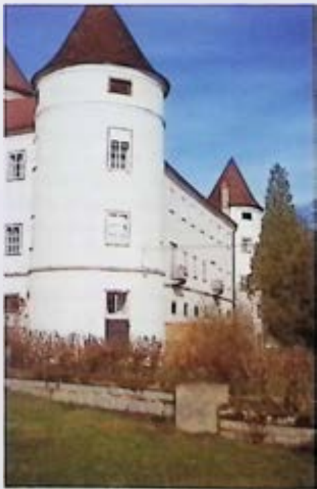
Schwertberg, Schloss, Südseite nach Restaurierung. – Foto: BDA
