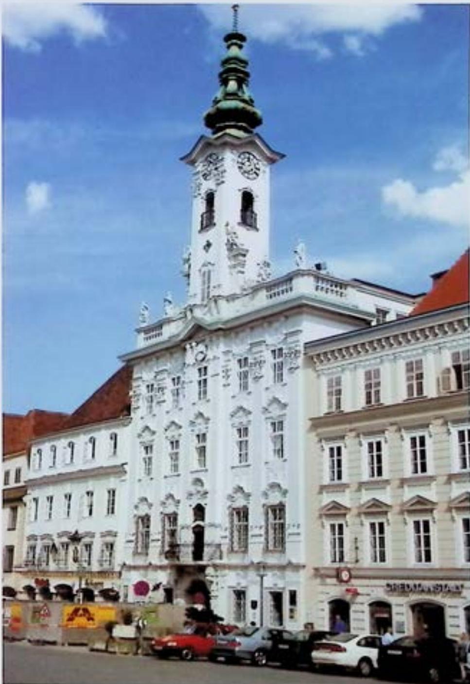
Steyr, Stadtplatz 27, Rathaus, nach Restaurierung. – Foto: BDA
