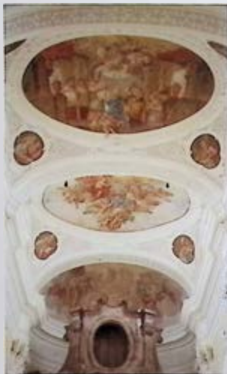
Kallham, Pfarrkirche, Chorgewölbe nach Restaurierung und Färbelung. – Foto: BDA
