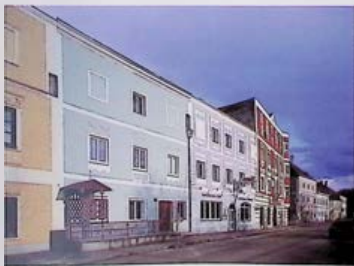
Aschach a.d.D., Ritzbergerstraße 6 und 7. – Foto: BDA
