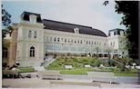
Bad Ischl, Kurhaus, nach Sanierung und Adaptierung. – Foto: BDA
