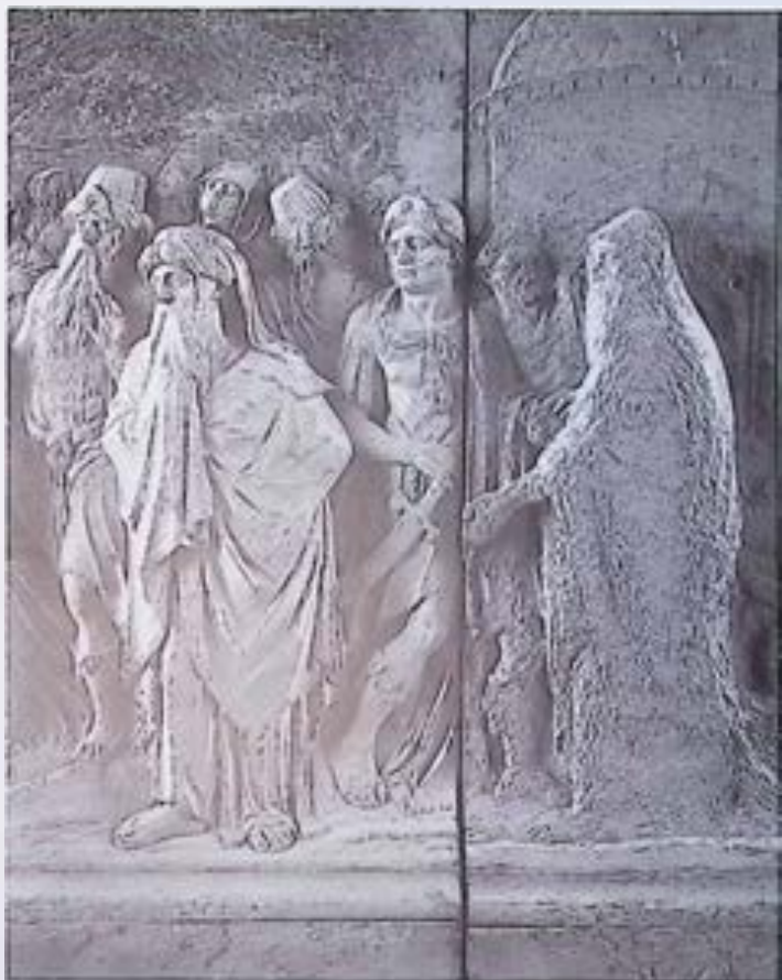
Ausschnitt aus dem Relief mit der Auferweckung des Lazarus: Formverluste durch unterschiedliche Feuchte- und Salzeinwirkung (Aufnahme nach Konservierung). - Foto: BDA.
