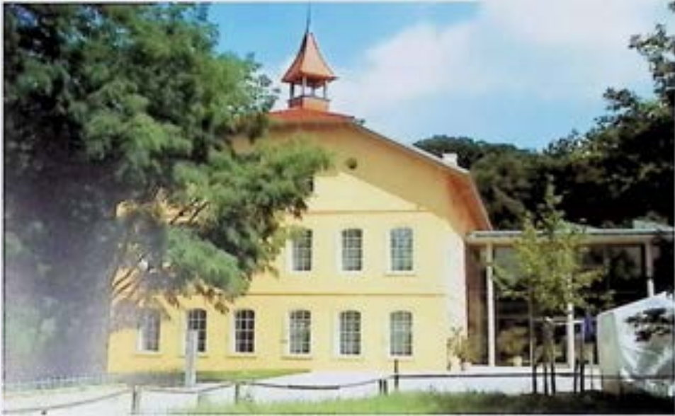
Pregarten, Bruckmühle, nach Sanierung und Adaptierung. – Foto: BDA
