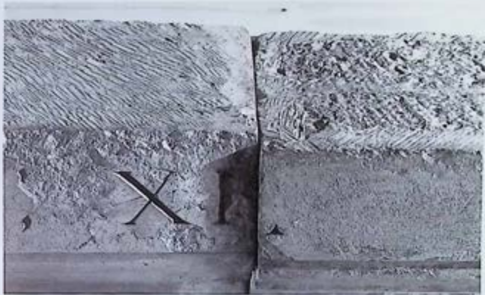
Oberseite der Reliefplatten mit originalen Werkzeugspuren.-. Foto: BDA.
