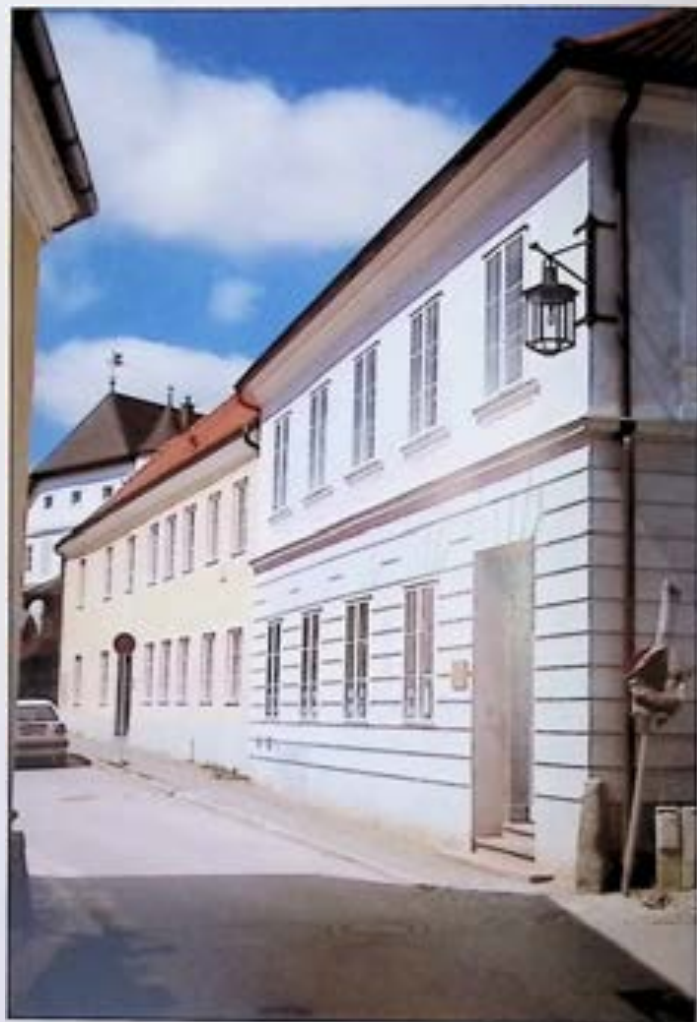
Steyr, Sierninger Straße 78 und 80, nach Instandsetzung. – Foto: BDA
