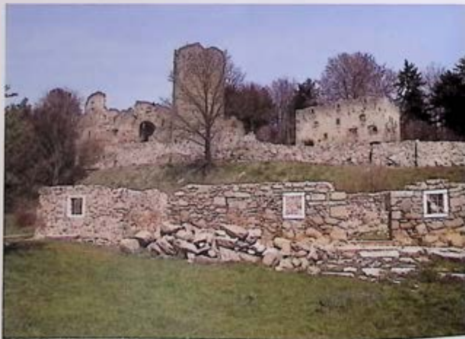
Prandegg, ehem. Meierhof unterhalb der Burgruine, Stalltrakt während der Konservierung. – Foto: BDA
