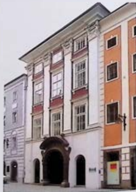
Linz, Pfarrplatz 17, ehem. Garstener Stiftshaus, nach Sanierung. – Foto: BDA
