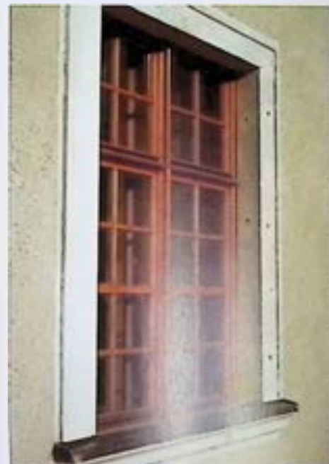
Dieselbe Situation nach Sanierung der Sohlbankverblechungen unter Anwendung von Bleiblech.
