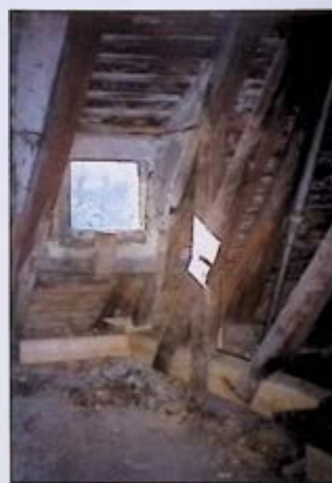
Kontrollpunkt Dachgaube: begrenzte handwerksgerechte Dachstuhlreparatur hat Vorrang vor Totalerneuerung.
