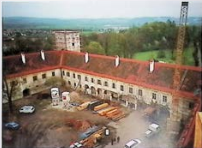
Enns, Schloss Ennsegg, während der Instandsetzung nach Sanierung der Altdeckung
