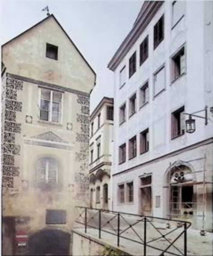
Steyr, Kirchengasse 6, nach Freilegung und Restaurierung der spätbarocken Fassadenmalerei. – Foto: BDA.
