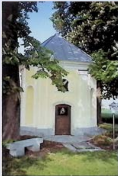
Berg an der Krems, Napoleonkapelle, nach Restaurierung. – Foto: BDA
