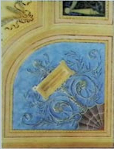
Eferding, Katholischer Friedhof, Deckenmalerei in der Eingangshalle nach Restaurierung Foto: T. Dimmel
