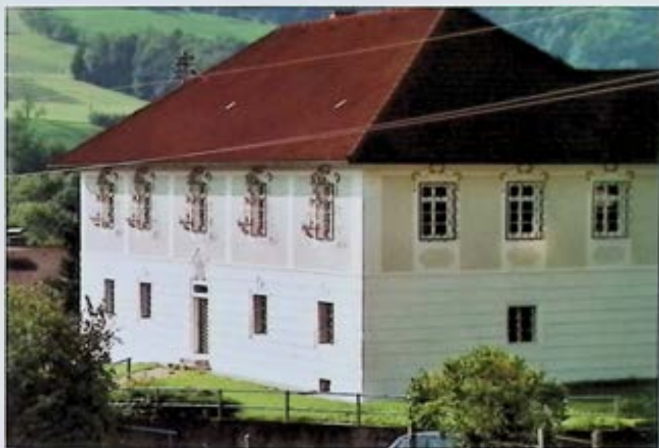
Untergrünburg Nr. 90, nach Restaurierung der Stuckfassaden. – Foto: W. Luckeneder
