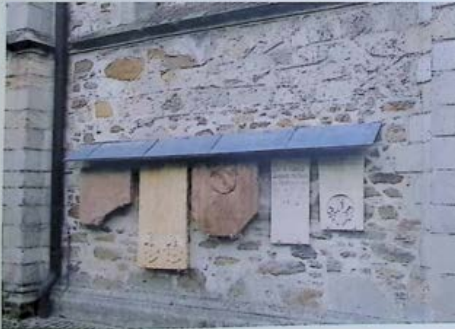
Eferding, Stadtpfarrkirche, Grabplatten am Außenbau nach Konservierung Foto: BDA
