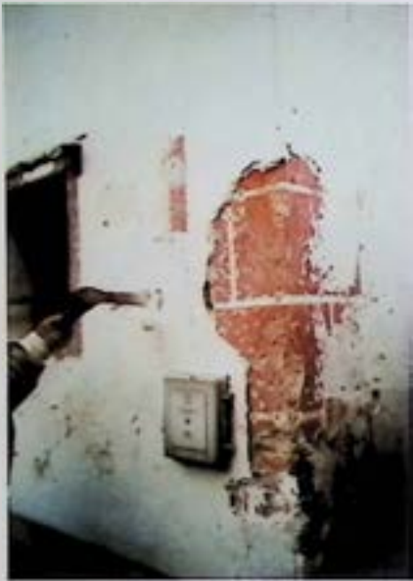
Gemalte barocke Eckgliederung am Außenbau unter späteren Übertünchungen.
