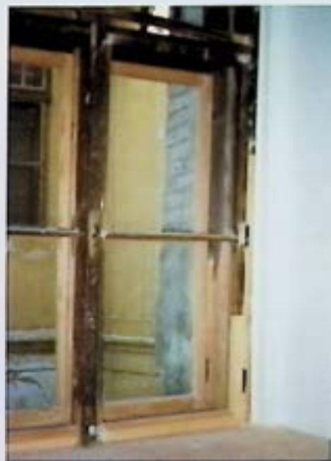
Beispiel einer angepassten Fensterreparatur.
