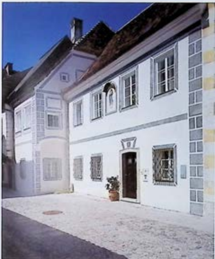
Steyr, Berggasse 38, nach Freilegung und Restaurierung der frühbarocken Putzfassade. – Foto: W. Ebenhofer.
