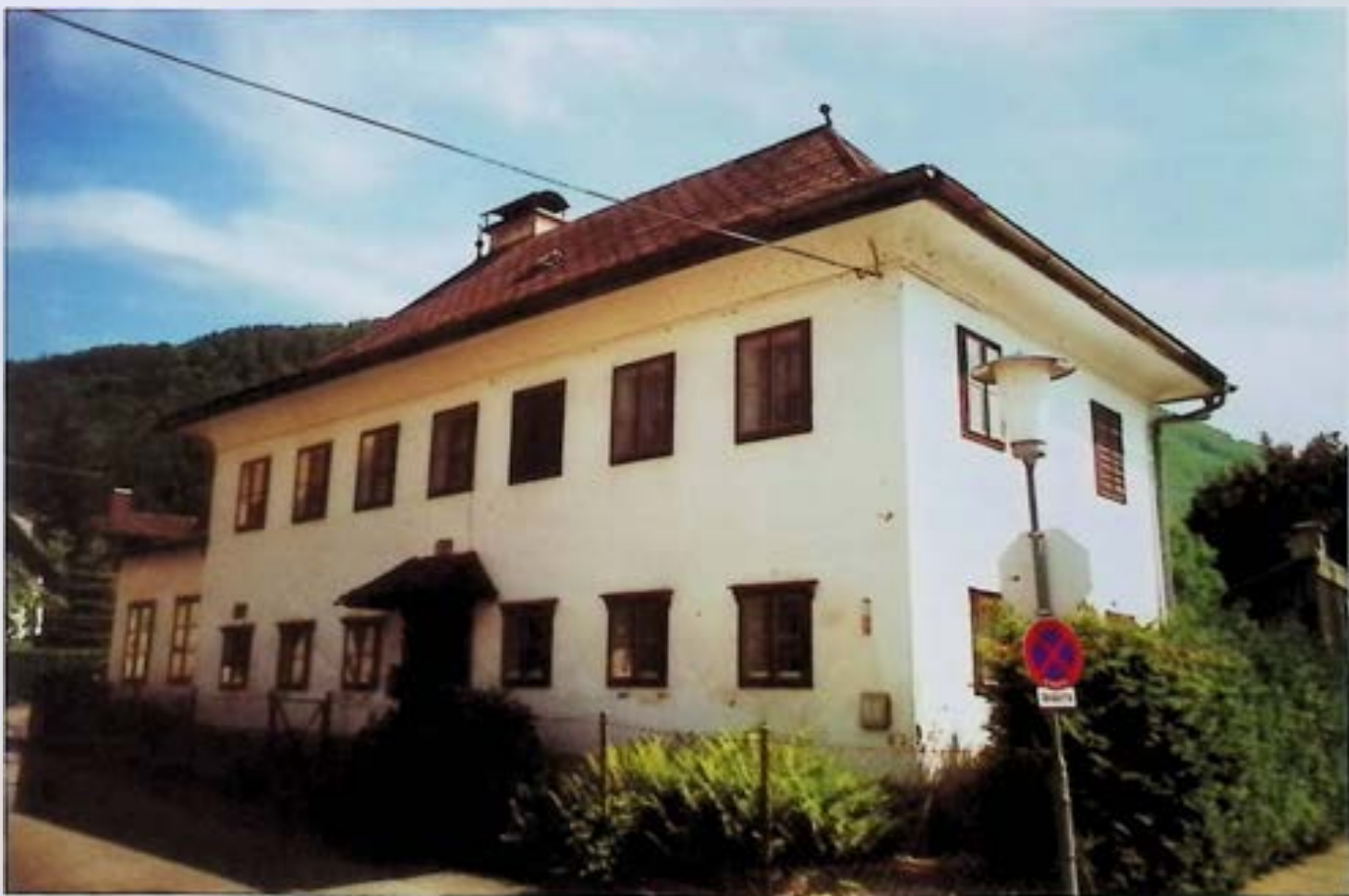
Ehem. Hofkastnerhaus in Gmunden, Außenbau. - Foto: alle BDA.
