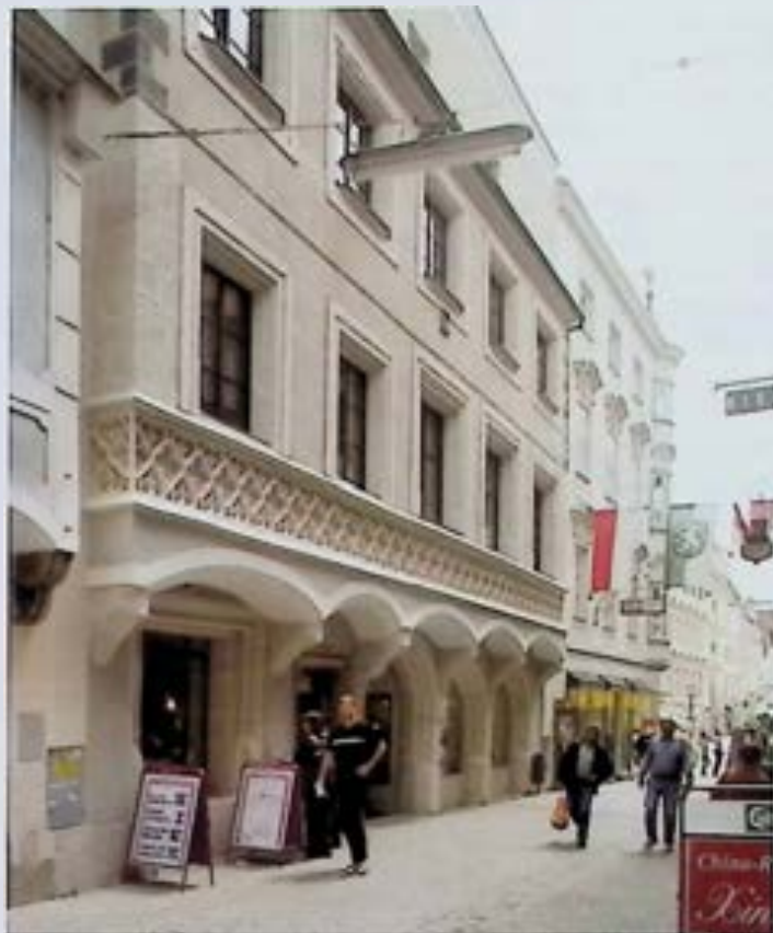
Steyr, Enge Gasse 31, Fassade nach Steinrestaurierung. – Foto: BDA.
