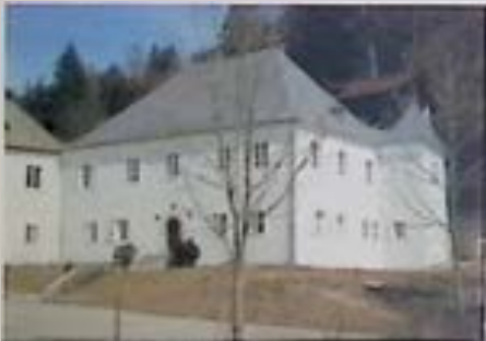
Friedburg, Pfarrhof, nach Außeninstandsetzung. – Foto: BDA
