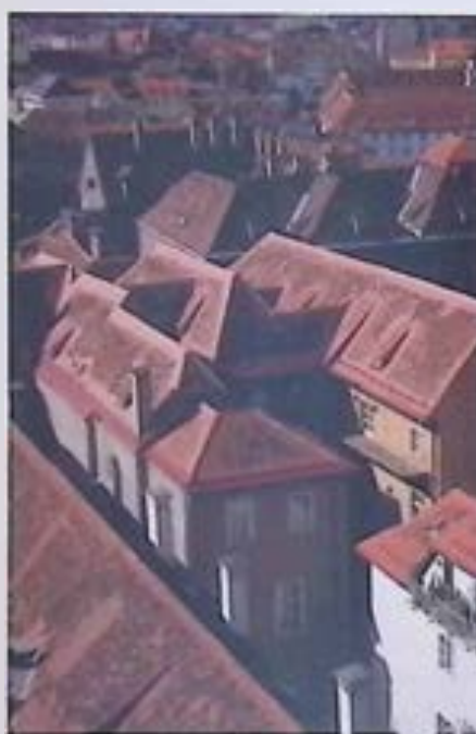
Bestandserhaltung durch Reparatur: Sanierte Altziegeldeckungen in der Grazer Altstadt.
