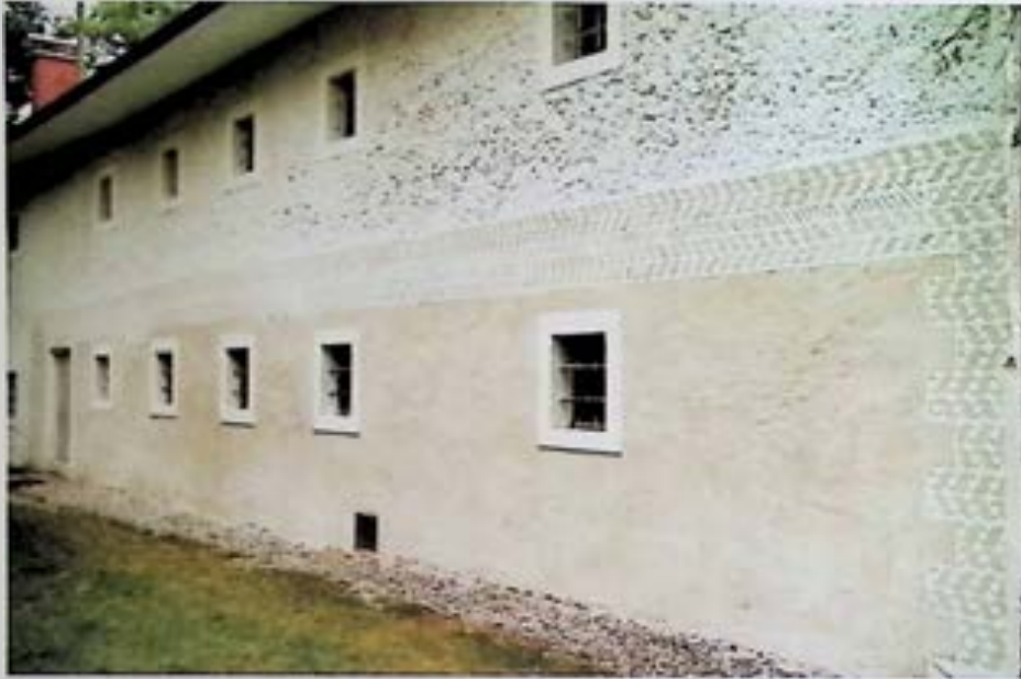
Vorchdorf, Lederau 17, nach Restaurierung der Sgraffitofassade von 1581. – Foto: T. Dimmel
