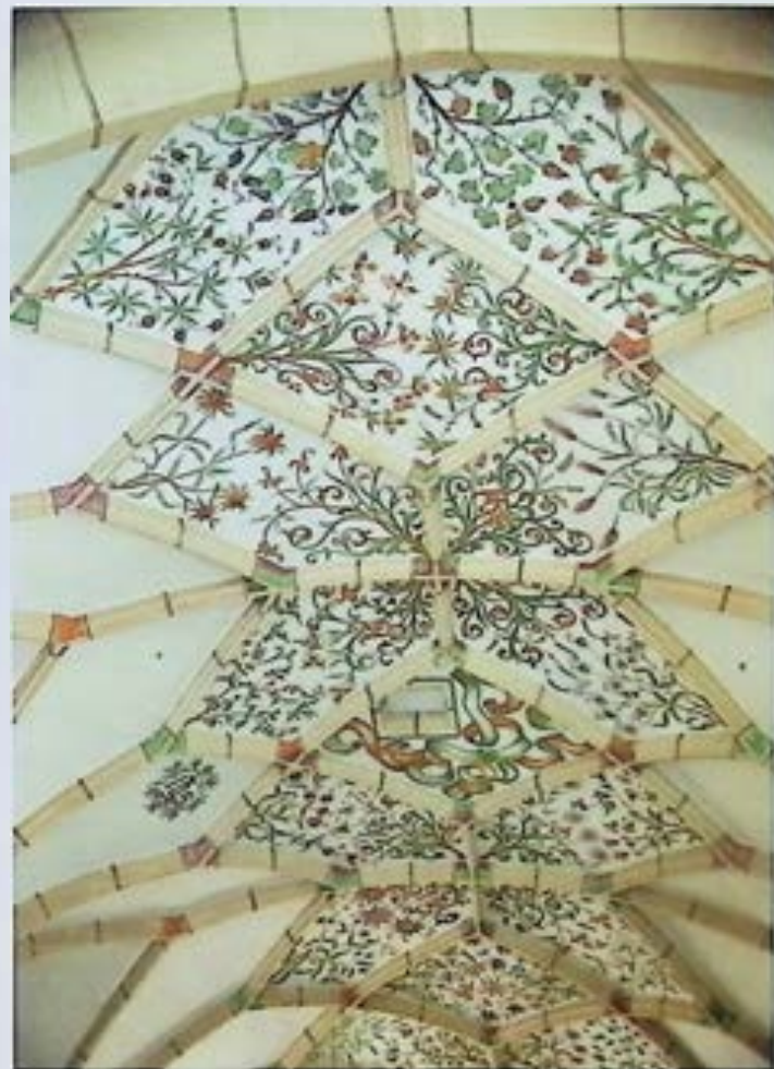
Kirchham, Pfarrkirche; Langhauswölbung nach Restaurierung Foto: W. Luckeneder
