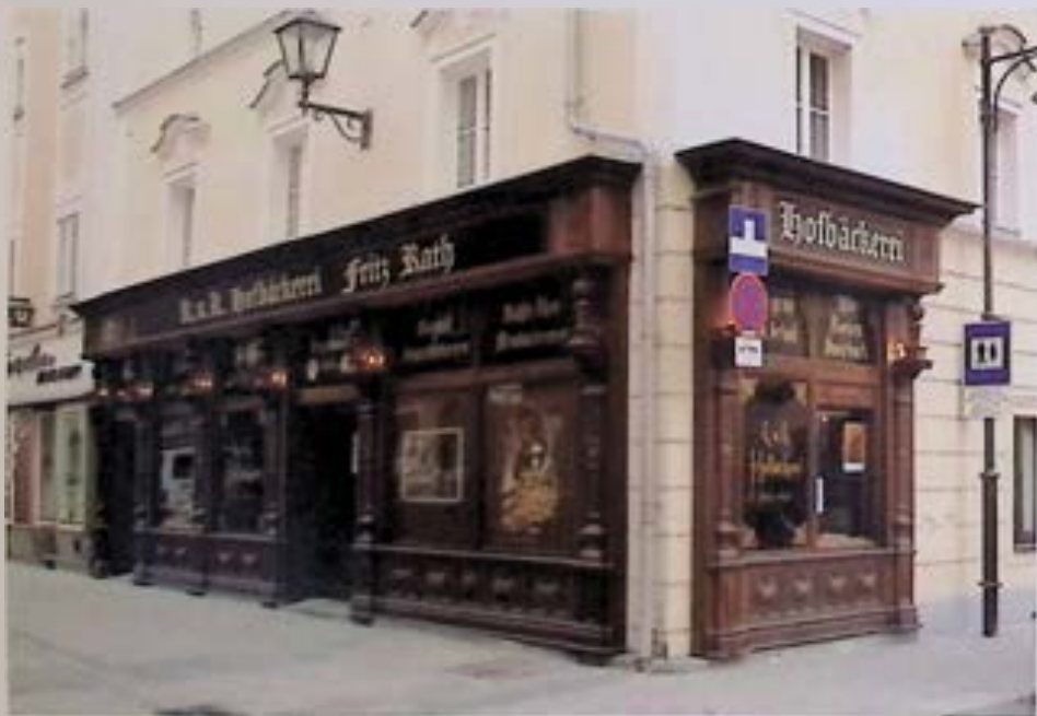
Linz, Pfarrplatz 15, Geschäftsportal von 1889 nach Restaurierung. – Foto: BDA
