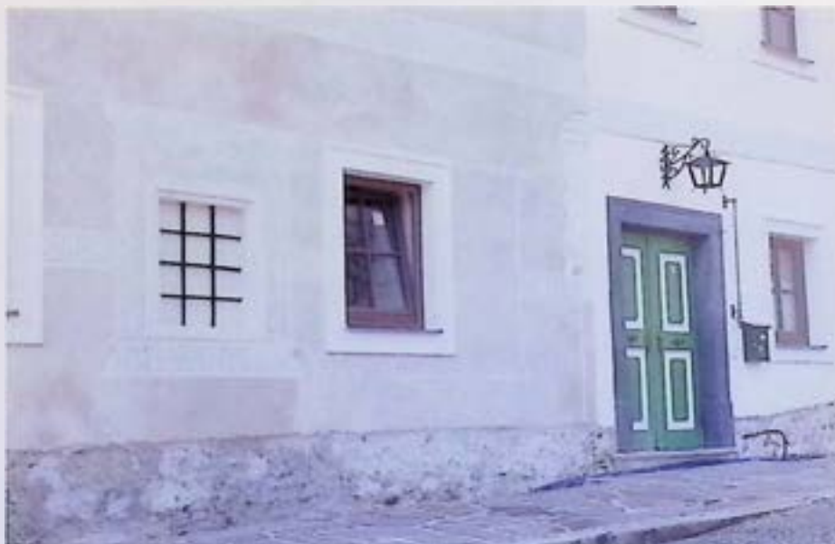
Ternberg, Trattenbachstraße 15, Sgraffitorestaurierung. - Foto: BDA.
