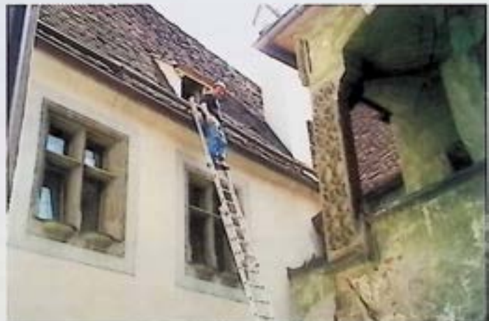
Dachinspektion am Haus Steyr, Kirchengasse 16 (Dunklhof). - Foto: BDA.
