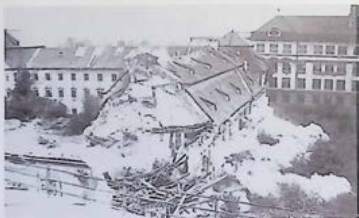
Sprengung der ehem. Linzer Wollzeugfabrik von Johann Michael Pruner von 1722 - 26 im Jahr 1969. – Foto: Archiv der Stadt Linz.
