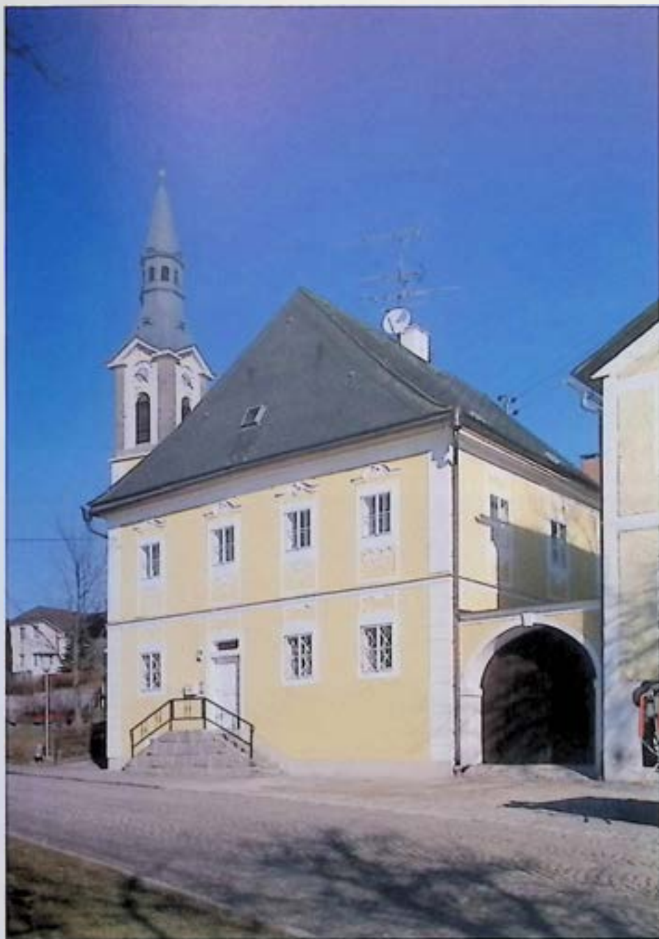
Niederkappel, Pfarrhof, Stuckfassade nach Restaurierung. - Foto: BDA.
