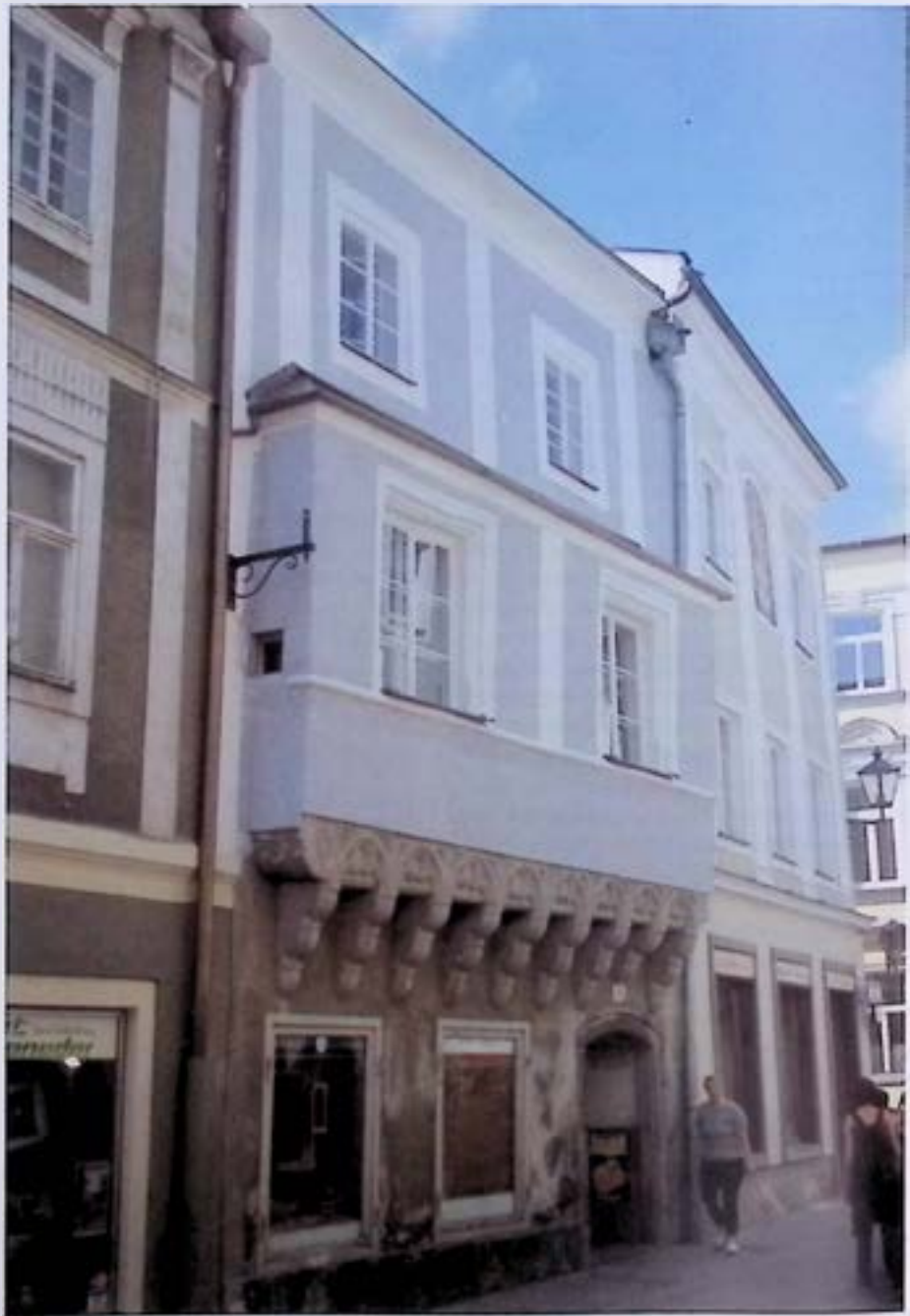
Freistadt, Eisengasse 4, nach Fassadenrestaurierung. - Foto: BDA.
