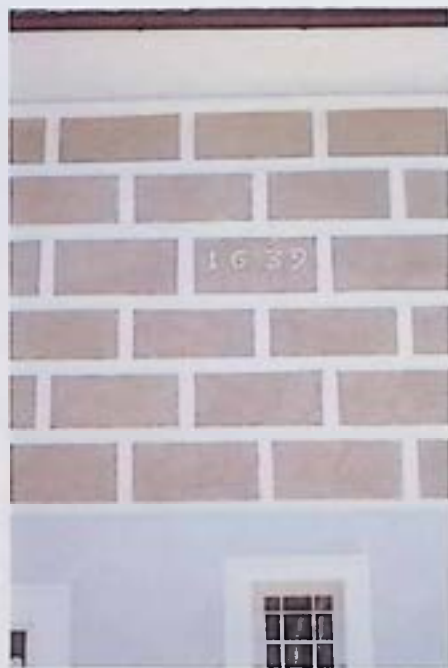
Steyr, Sepp - Stöger - Straße 9, nach Fassadenfreilegung. - Foto: BDA.
