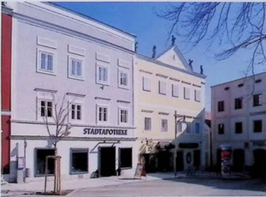
Eferding, Stadtplatz 15 und 16, nach Instandsetzung. - Foto: BDA.
