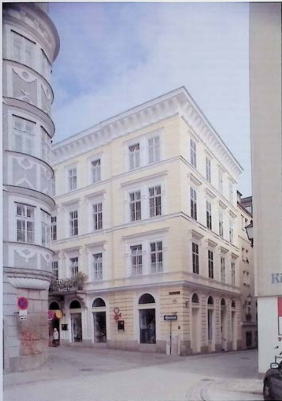
Linz, Rathausgasse 9-11, nach Fenstersanierung. - Foto: BDA.
