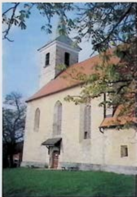
Weigersdorf, Filialkirche, nach Maßnahmen am Turm, Langhaus im überlieferten Alterswert. Foto: BDA.
