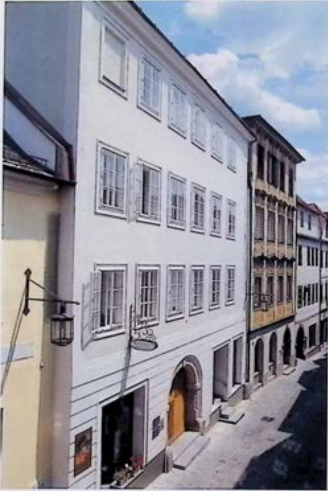
Steyr, Gleinkergasse 16, Äußeres nach Instandsetzung. - Foto: BDA.
