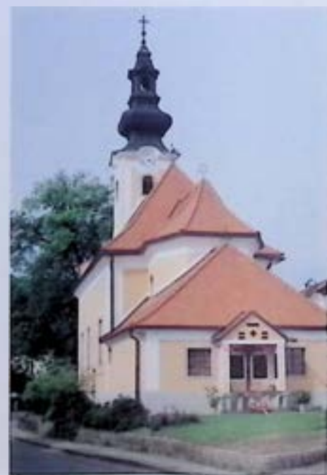
Klam, Pfarrkirche, Außenbau nach Instandsetzung. - Foto: BDA.
