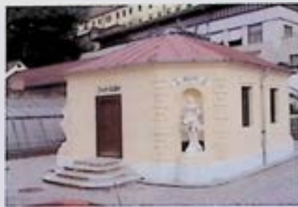
Lambach, Stift, Fischkalter von 1887/88, nach Instandsetzung. - Foto: BDA.
