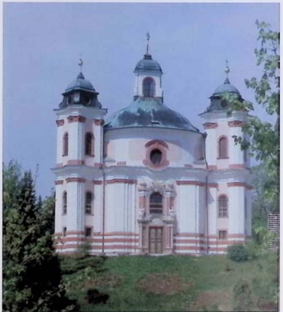
Stadl-Paura, Pfarr- und Wallfahrtskirche, nach Außenrestaurierung. - Foto: BDA.
