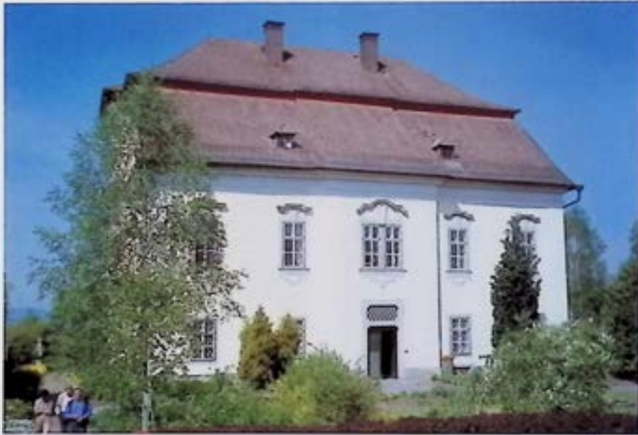
St. Peter am Wimberg, Pfarrhof, nach Instandsetzung der Fenster. - Foto: BDA.
