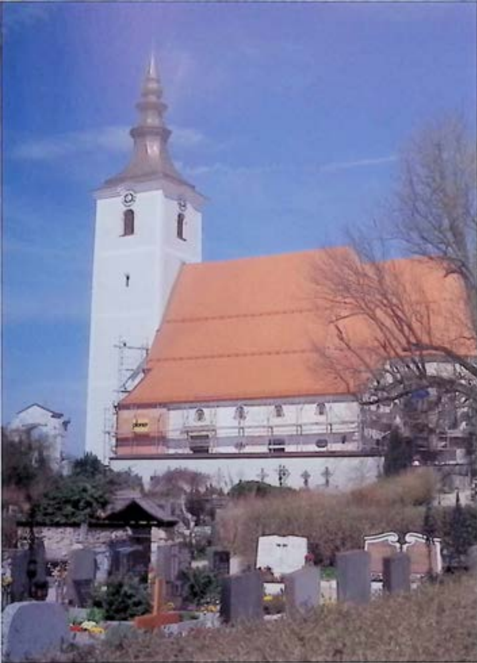
Seewalchen, Pfarrkirche, Außenbau nach Turmsanierung und Dachdeckung. - Foto: BDA.
