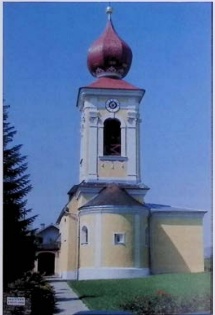
Pfaffing, Filialkirche, Äußeres nach Restaurierung. - Foto: BDA.
