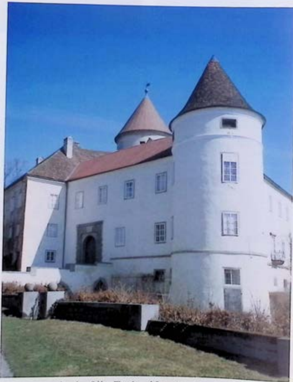
Schwertberg, Schloss, Westseite nach Restaurierung. - Foto: BDA.
