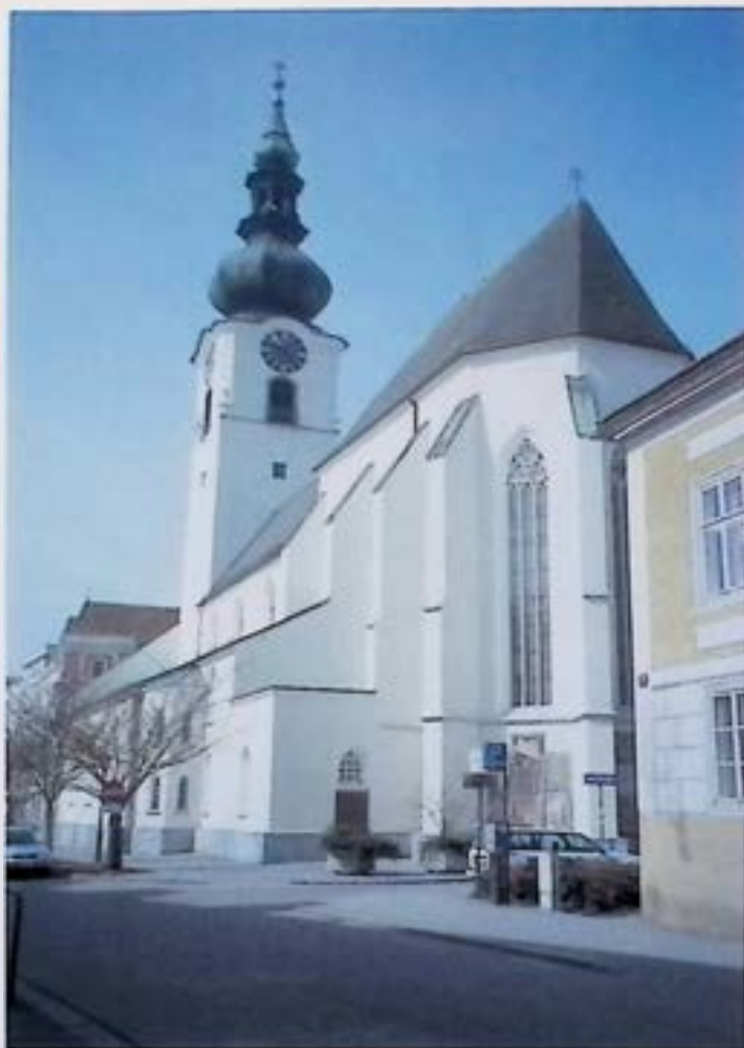
Wels, Stadtfarrkirche, nach Außensanierung. - Foto: BDA.
