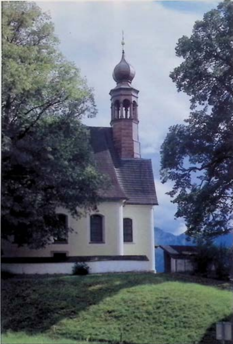
Mondsee, Filialkirche Maria Hilf, Turmsanierung. - Foto: BDA.
