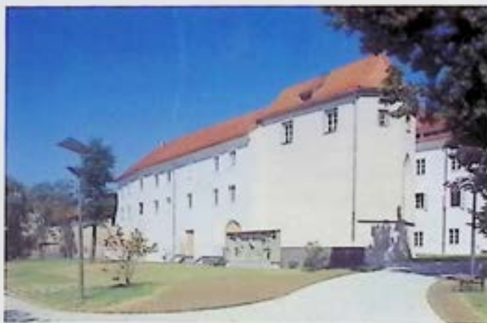
Restaurierung und Umgestaltung zur Landesausstellung 2000: Ehem. Minoritenkloster in Wels. - Foto: BDA.
