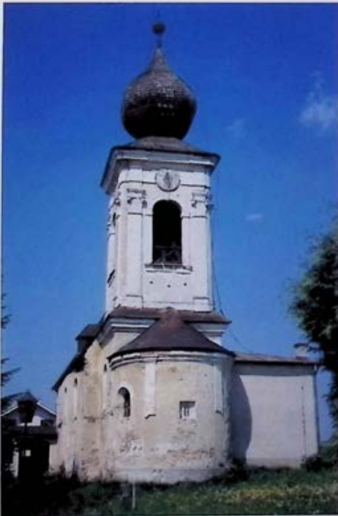
Pfaffing, Filialkirche, Außenbau vor Restaurierung. - Foto: BDA.
