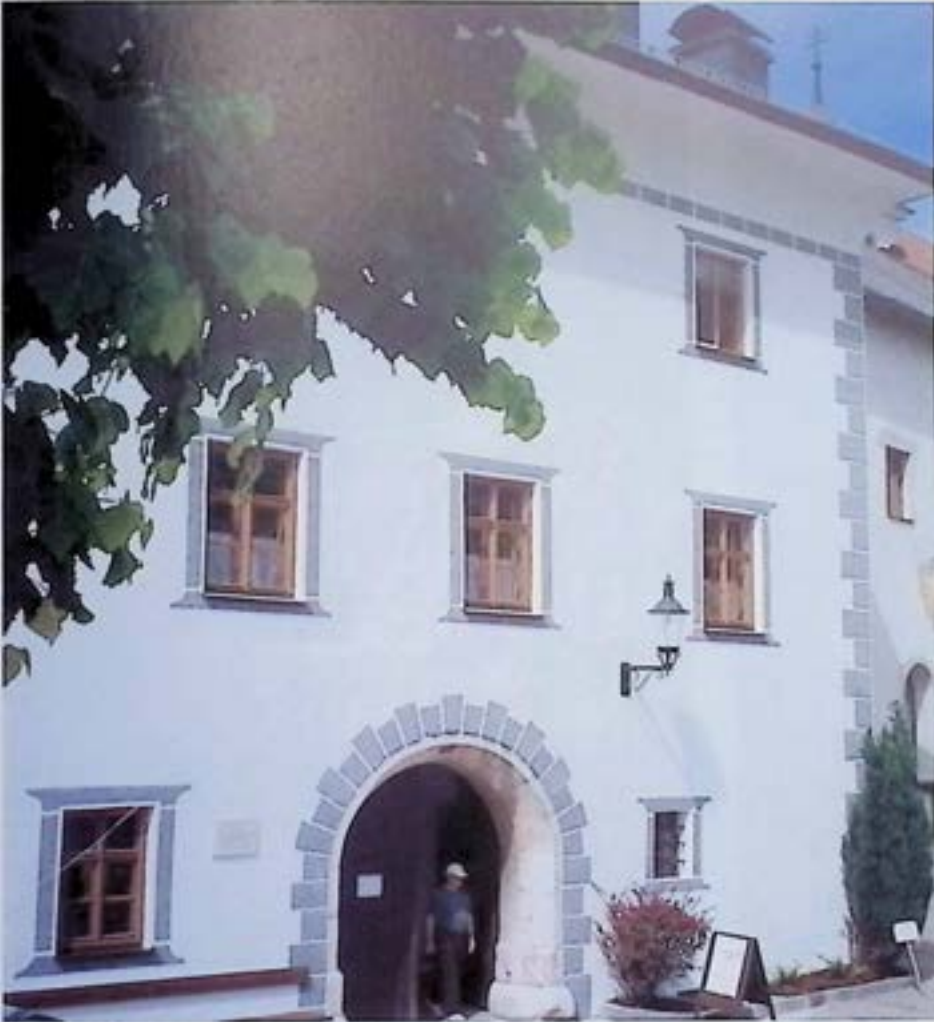
Traunkirchen, ehem. Klostergebäude, Südfassade nach Außeninstandsetzung. - Foto: BDA.
