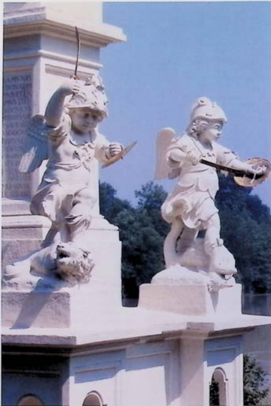
Wernstein, Mariensäule, Putti am Säulensockel nach Konservierung mit Kalkschlämme. - Foto: BDA
