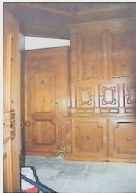
Mondsee, Filialkirche Maria Hilf, Sakristeinrichtung nach Freilegung und Restaurierung. - Foto: L. Linecker.
