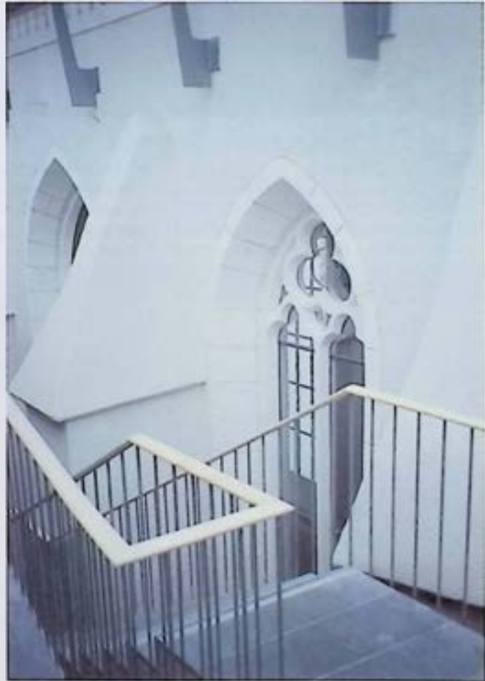
Wels, ehem. Minoritenkloster, Zwickel zwischen Chor und Kloster nach Freilegung des Chors, mit neuer Erschließung und Überdachung. - Foto: BDA.
