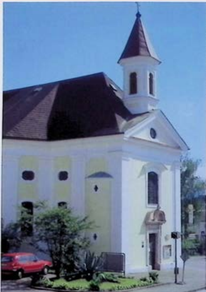
Vöcklabruck, Ägidiuskirche, nach Instandsetzung. - Foto: BDA.
