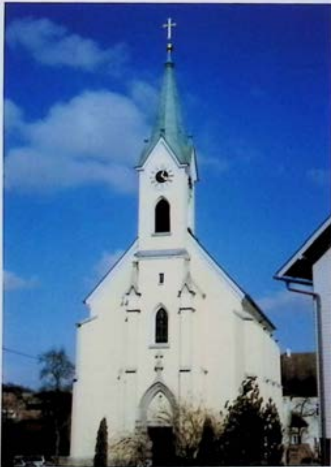
Bach bei Schwanenstadt, Expositurkirche, nach Außeninstandsetzung. - Foto: BDA.
