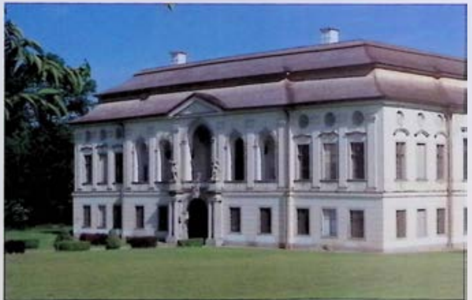
Hohenbrunn, Schloss, nach Holzschindeldeckung. - Foto: BDA.
