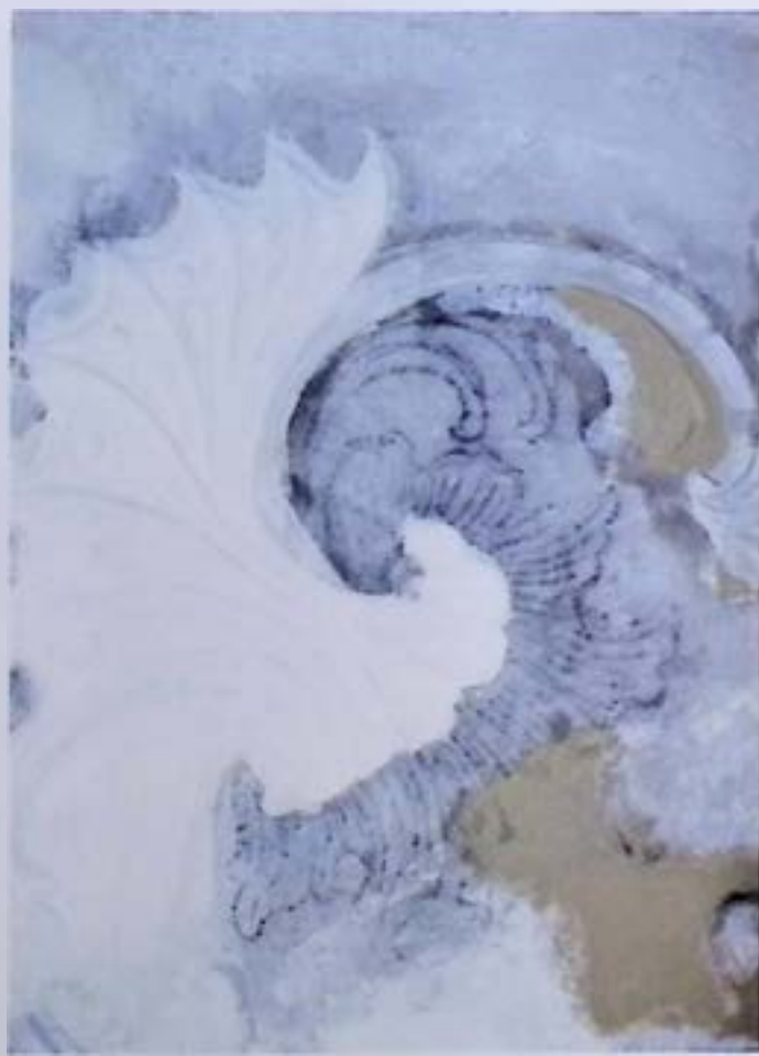
Buchkirchen bei Wels, Pfarrhof, Ergänzungsarbeit an der spätbarocken Stuckdecke im Osttrakt. - Foto: BDA.
