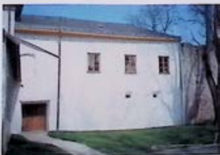
Wels, Altstadt 8, Stadtmauerseite nach Instandsetzung. - Foto: BDA.
