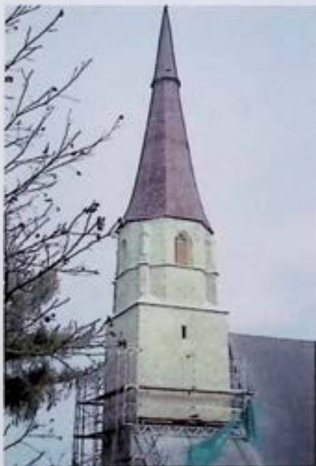
Rosßbach, Pfarrkirche, nach Turmsanierung. - Foto: BDA.
