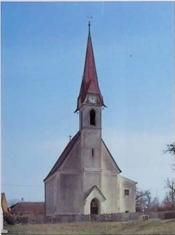
Holzhausen, Pfarrkirche, Außenbau vor Instandsetzung. - Foto: BDA.
