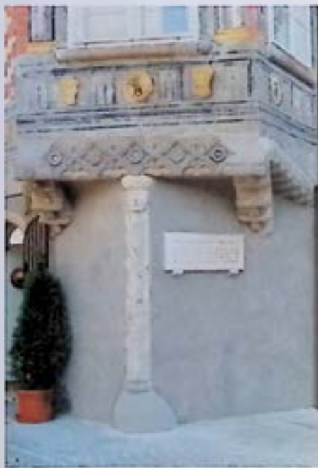
Wels, Stadtplatz 24, Erkersockel nach Steinrestaurierung. - Foto: J. Weninger.
