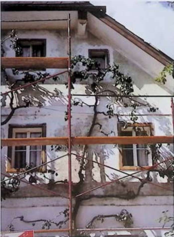
Reparatur eines Salzkammergutshauses durch punktuelle Putzausbesserungen hinter dem Spalierobst. – Foto: BDA
