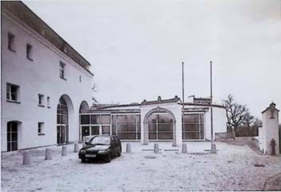
Geschichte als Versatzstück. Die Anerkennung der Geschichtsdenkmale wird von ihrer Verfügbarkeit bestimmt. Der ehemalige Speicherbau eines Schlosses kann nun überall und alles sein; statt historischer Identität Beliebigkeit. – Foto: BDA.
