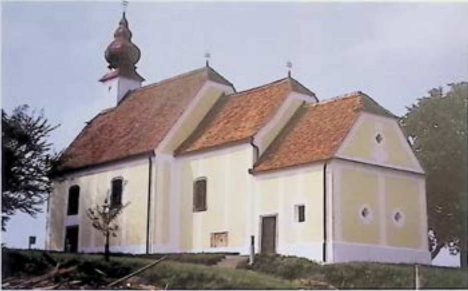
Ruprechtshofen, Filialkirche, nach Sanierung der historischen Ziegeldeckung. – Foto: BDA.
