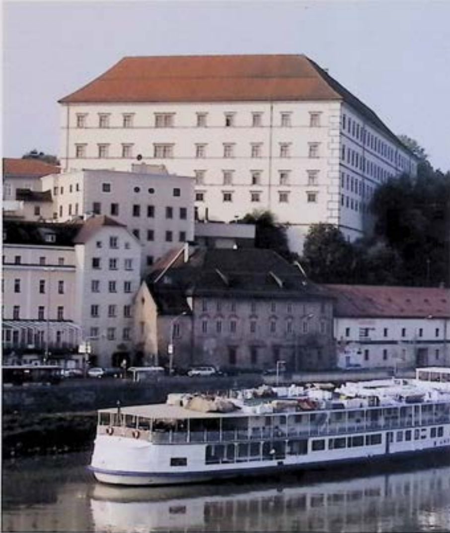
Linz, Tummelplatz 10, Schloß, nach Außeninstandsetzung. – Foto: BDA.
