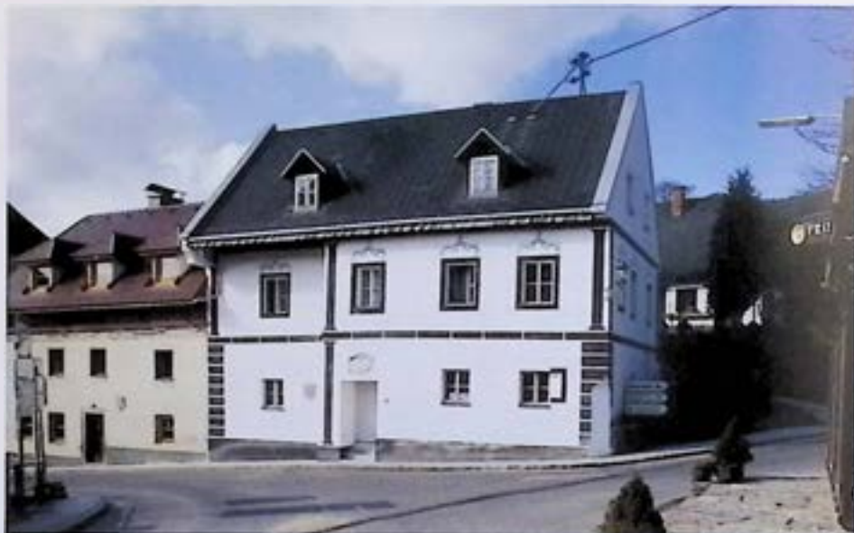
Windischgarsten 19, nach Fassadenrestaurierung. – Foto: BDA.
