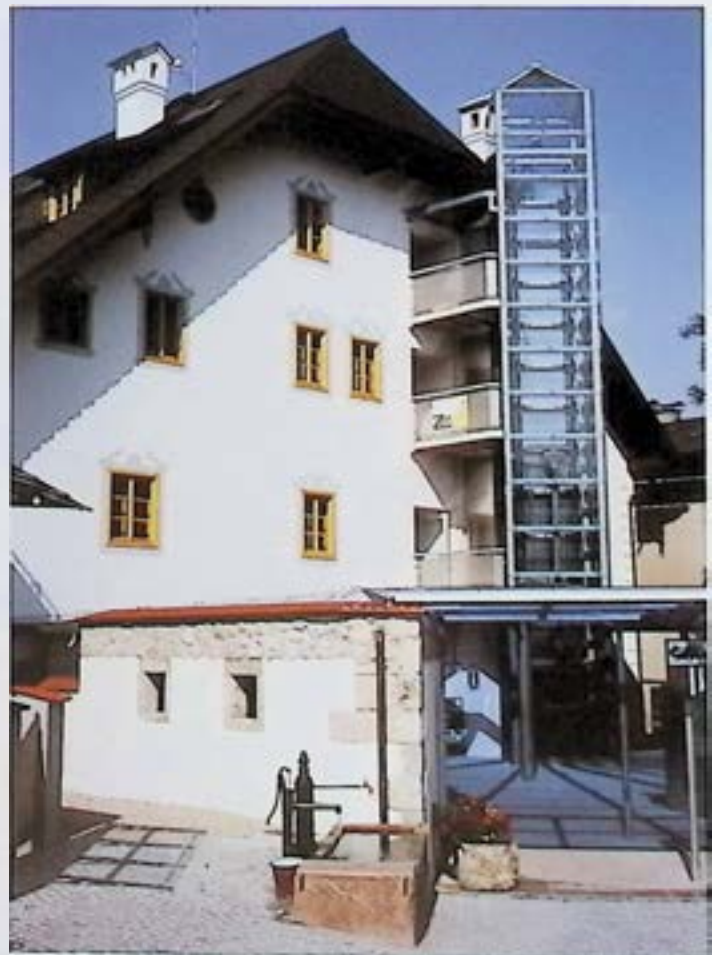
„Verschönerung“ eines Denkmals im Salzkammergut durch Nachahmung von barocken Fenstereinfassungen auf Neuputz und rustikale Zutaten. Der modernistische Außenlift signalisiert den Verwertungsdruck. – Foto: BDA.
