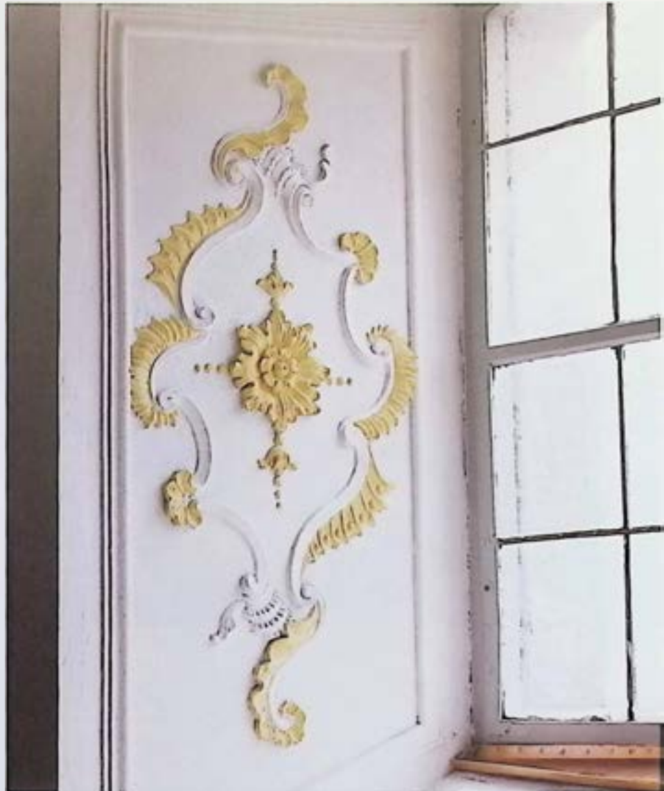
Kirchberg bei Kremsmünster, Filialkirche, Rokokostuck nach Restaurierung und Fassung nach Originalbefund. – Foto: Sulzgruber
