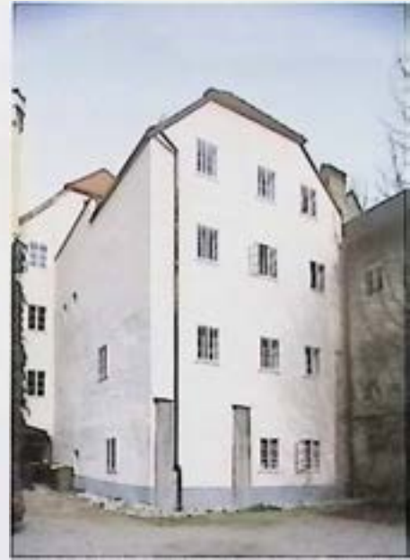
Wels, Stadtplatz 65, Hinterhaus nach Instandsetzung. – Foto: BDA.
