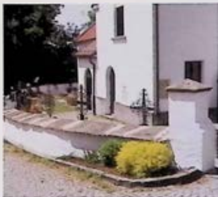
St. Radegund, Friedhofsmauer, nach denkmalgerechter Sanierung. – Foto: BDA.
