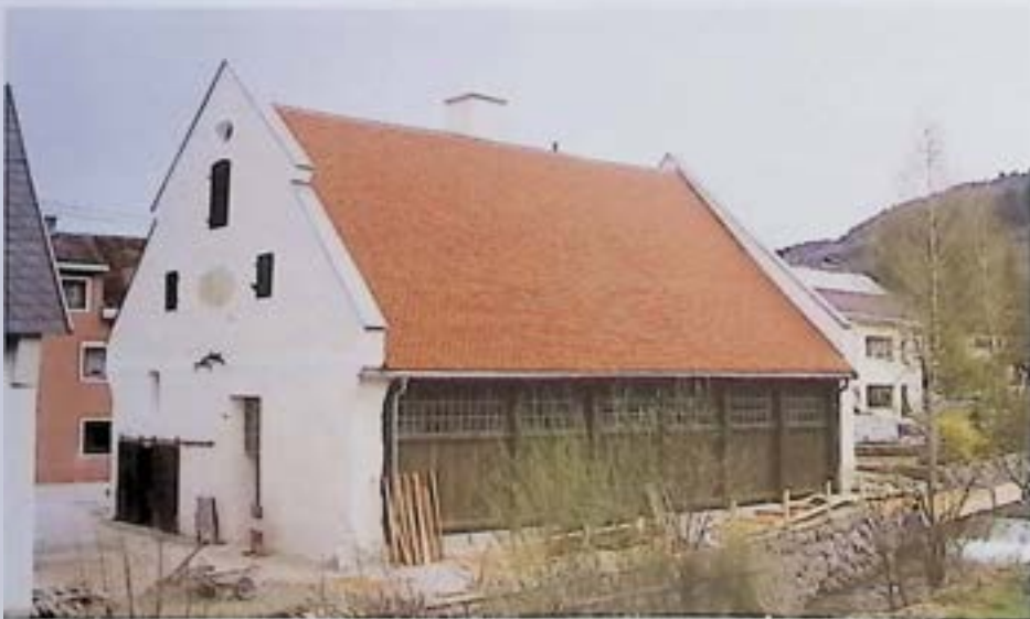
Spital am Pyhrn, Lindemayrschmiede, Außenbau nach Instandsetzung. – Foto: BDA.
