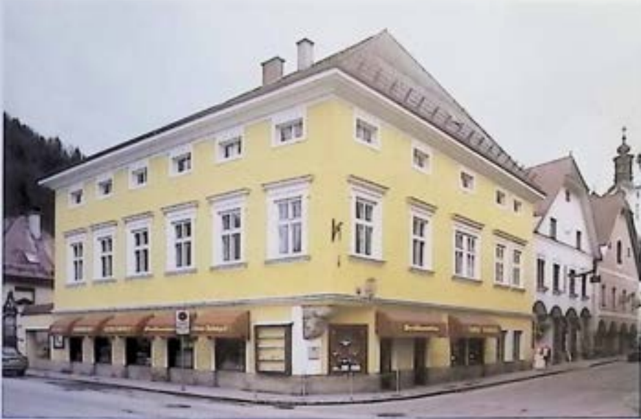
Weyer, Oberer Markt 1, nach Fassadensanierung. – Foto: BDA.
