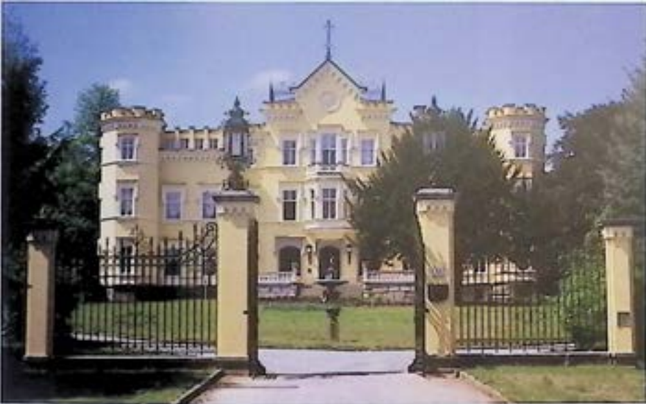
Steyr, Preuenhuberstraße 14, Schloß Voglsang ab 1877, nach Sanierung. – Foto: BDA.
