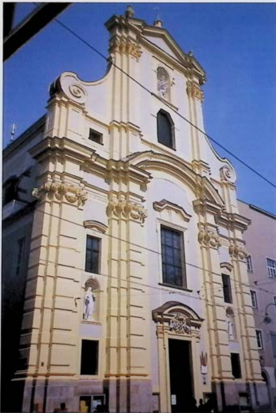
Linz, Karmeliterkirche, Fassade 1722, nach Instandsetzung und Färbelung gemäß Originalbefund. Foto: BDA.
