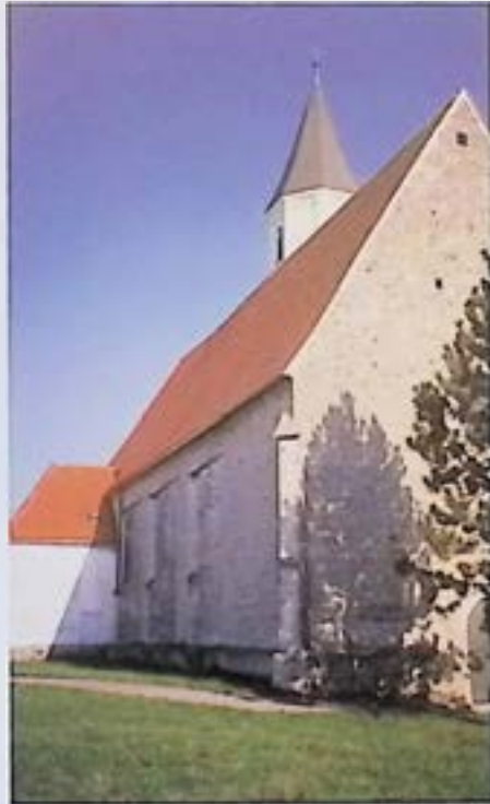
Münsteur, Pfarrkirche, nach Erneuerung der Ziegelddeckung. – Foto: BDA.
