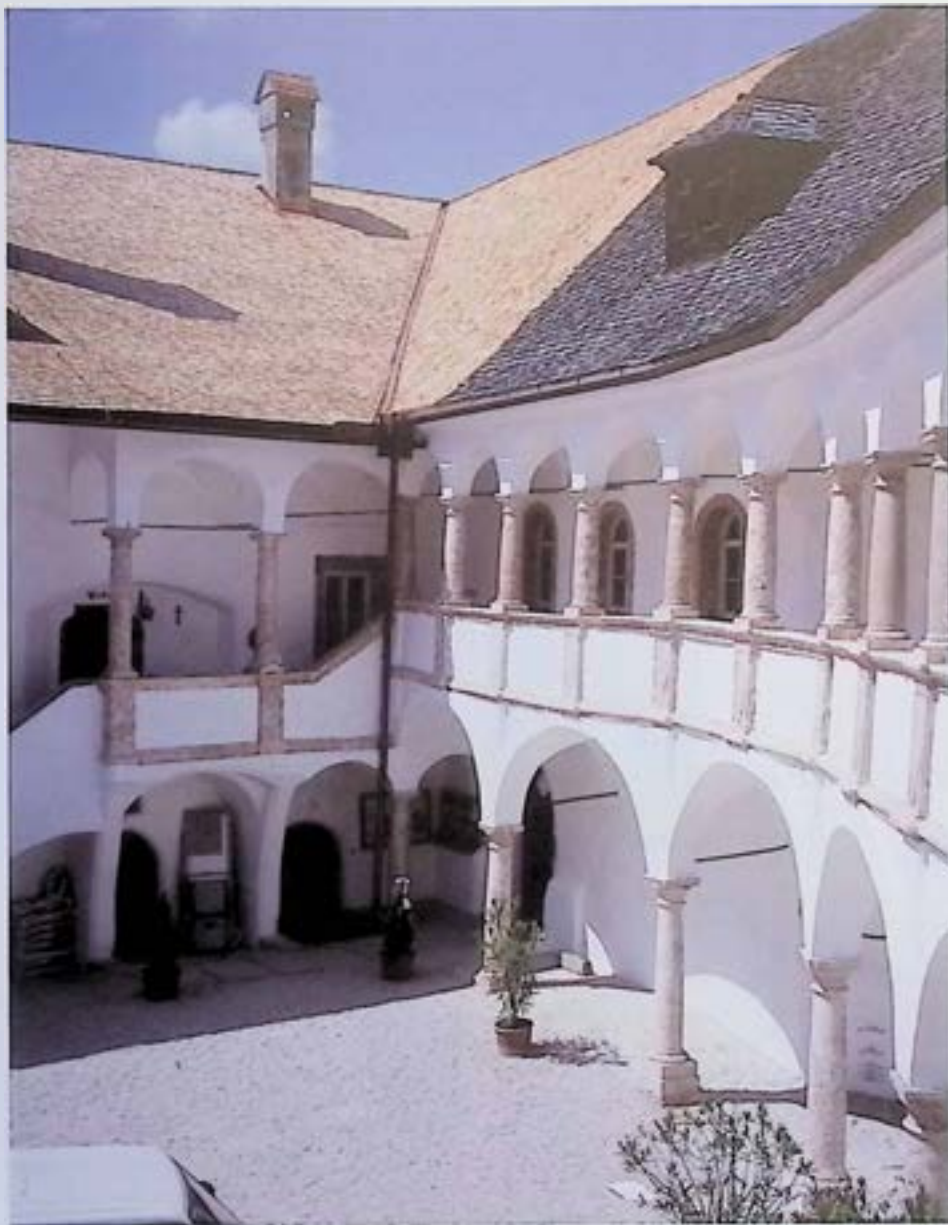
Gmunden, Seeschloß Ort, Arkadenhof nach Restaurierung. – Foto: BDA.
