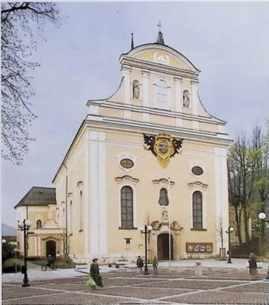
Bad Ischl, Pfarrkirche 1769-80, nach Außeninstandsetzung, – Foto: BDA.
