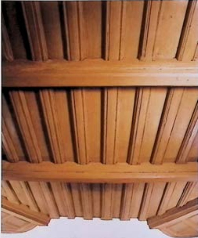
Steyr, Sepp-Stöger-Straße 13, Petzengütl, Holzriemlingdecke nach Freilegung und Restaurierung. – Foto: Ebenhofer.
