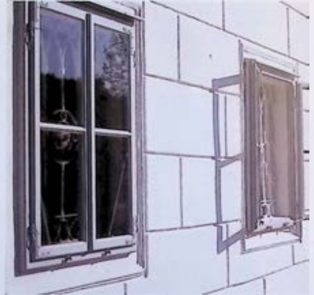
Scharnstein, Grubbachstraße 14, Geyerhammer – Herrenhaus, Winterfenster im Erdgeschoß nach Wiederherstellung. – Foto: BDA.
