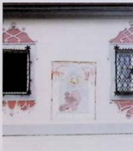
Arzberg 1, ehemalige Forsthube, Fassadendetail nach Außenrestaurierung. – Foto: BDA.
