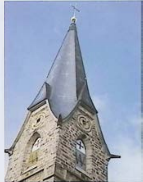
Bad Leonfelden, Pfarrkirche, nach Erneuerung der neugotischen Eindeckung mit Naturschiefer. Foto: BDA.
