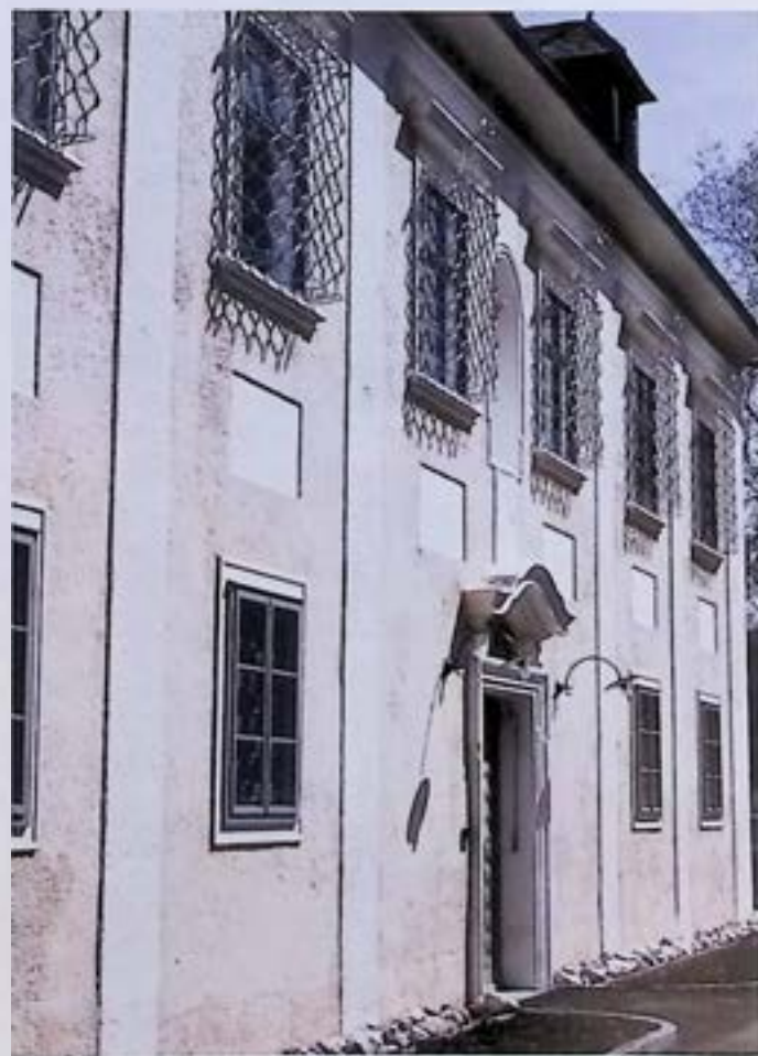
Traditionelle Kalkfärbelung und Fensterreparatur gewährleisten den authentischen Zustand des Denkmals. Reparatur im System der überlieferten Baustoffe wird zum Ausweg aus der Irreversibilität neuer Ersatzmaterialien. – Foto: BDA.
