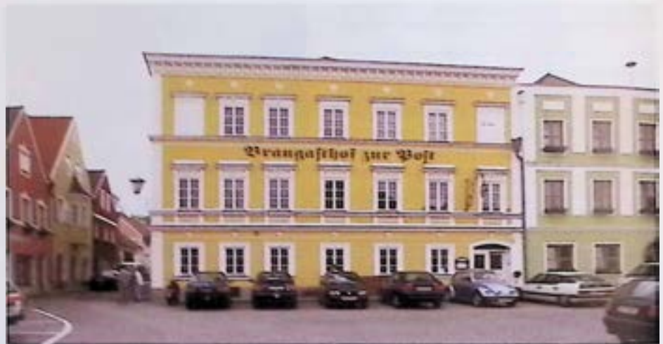
Obernberg, Marktplatz 8, nach Sanierung und Außeninstandsetzung. – Foto: BDA.
