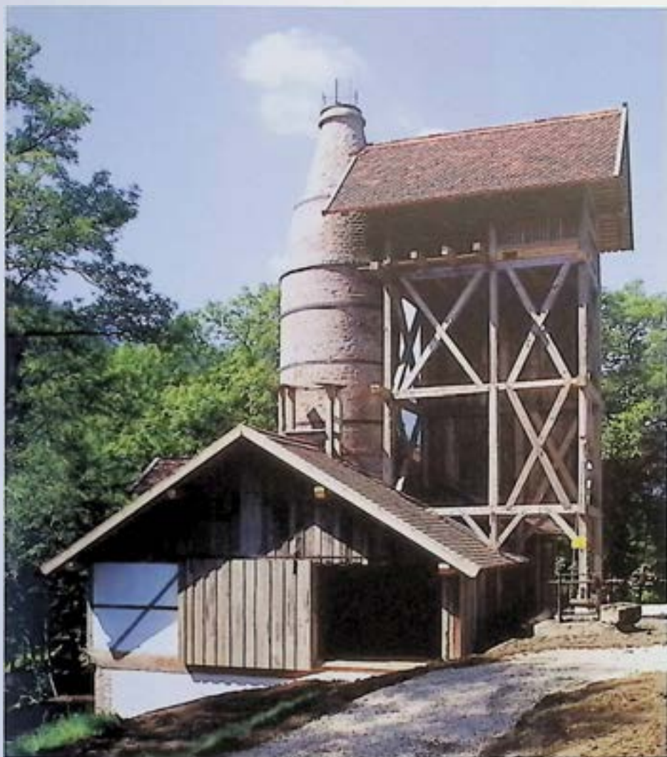
Steinbach am Ziehhberg, Kalkbrennofen, nach Sanierung. – Foto: BDA.
