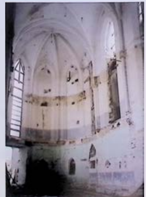
Wels, Minoritenplatz 1, ehemaliges Minoritenkloster, Chor der Klosterkirche um 1300 nach Entfernung der späteren Zwischengeschosse. Foto: BDA.
