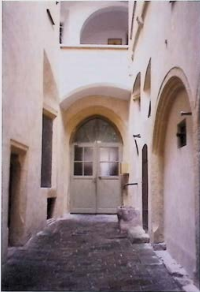
Steyr, Enge 31, gotischer Innenhof nach Instandsetzung. – Foto: BDA.
