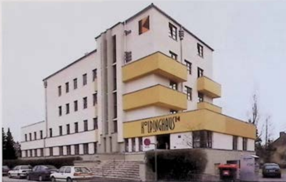
Wels, Kolpingstraße 20, Kolpinghaus 1930–32, nach Außeninstandsetzung. – Foto: BDA.
