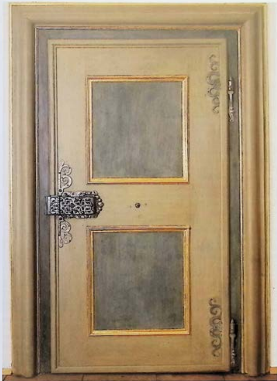
St. Pankraz, Pfarrhof von 1751–57, barocke Innentür nach Freilegung und Restaurierung. Foto: Ebenhofer
