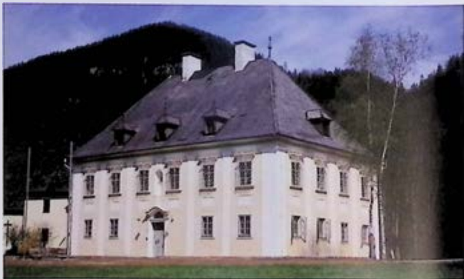
St. Pankraz, Pfarrhof von 1751–57, nach Restaurierung. – Foto: BDA.
