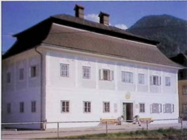
Scharnstein, Grubbachstraße 14, Geyerhammer – Herrenhaus mit Stuckfassade von 1826, nach Restaurierung. – Foto: BDA.
