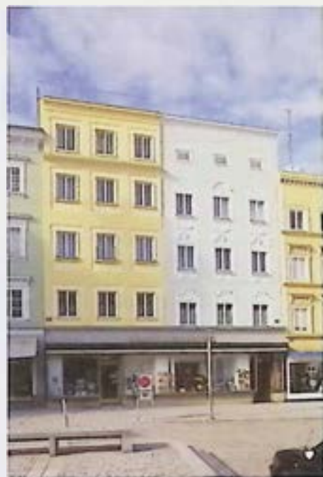
Ried im Innkreis, Hauptplatz 14–15, nach Fassadeninstandsetzungen. – Foto: BDA.
