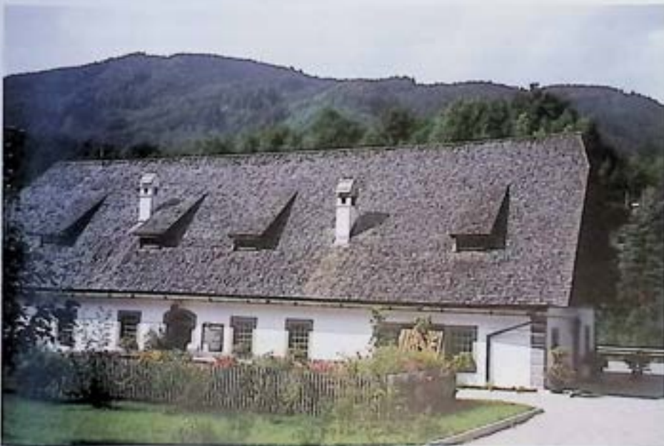
Weyer, Steyrer Straße 17, Balgsetzerhaus, Rückseite nach Freilegung und Instandsetzung der bauzeitlichen Putzfassade. – Foto: BDA.
